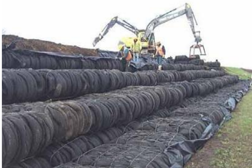
Figure 11: Mise en œuvre Tire balles (lazizi.Amina, 2014)
