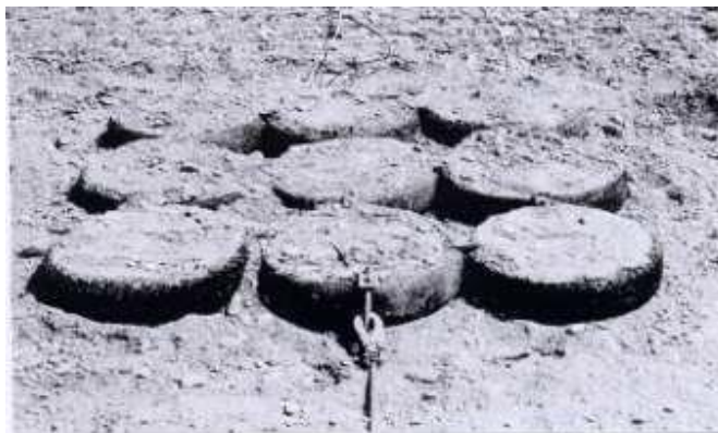
Figure 22 :Bandes de roulement sur chant en nappes (trame carrée). Vue avant remblaiement (LONG, 1993)
