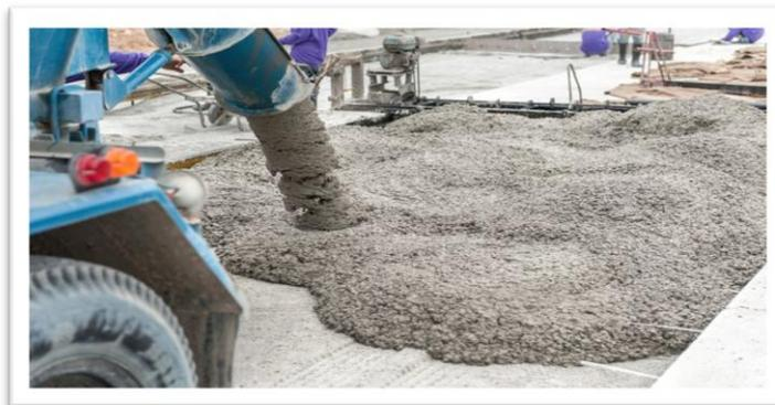
Figure 1.1: Le béton prêt à l'emploi [2]
