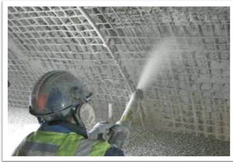
Figure 1.6: le béton projeté [2]
