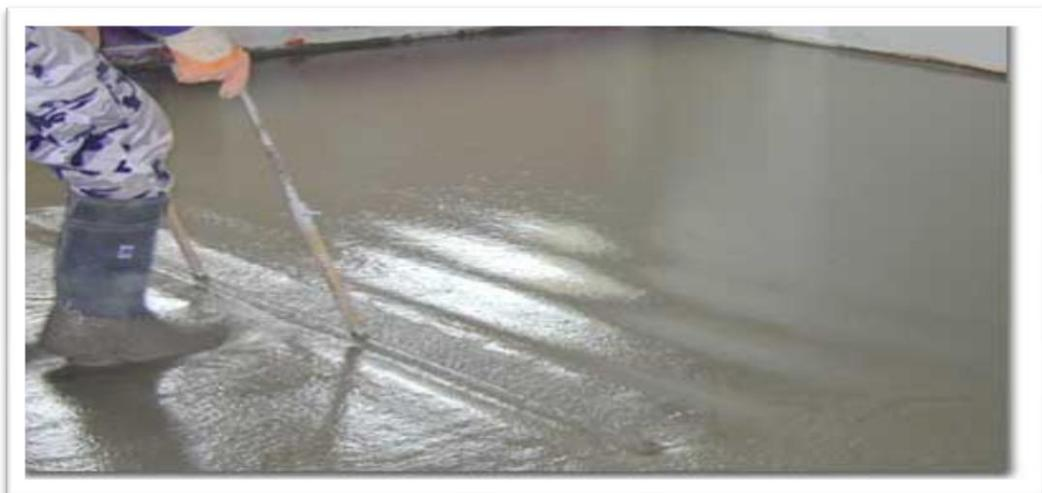
Figure 1.7: le béton auto plaçant [2]
