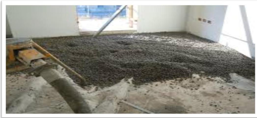
Figure 1.8: le Béton léger [2]
