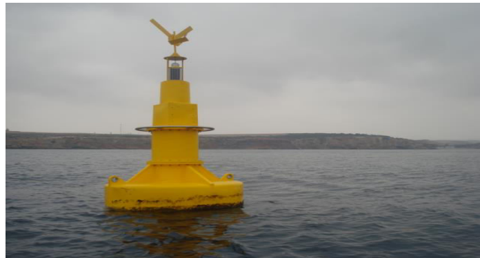
Photo 01: la tour de captage. [BWC]
