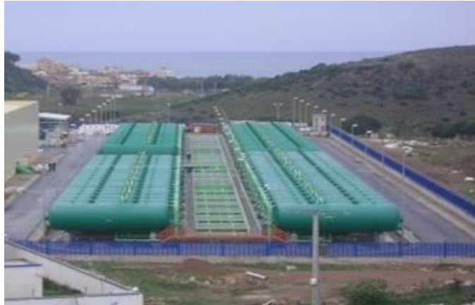
Photo05 :zone des filtres à sable et à anthracite de la SDEM de Béni Saf. [BWC]
