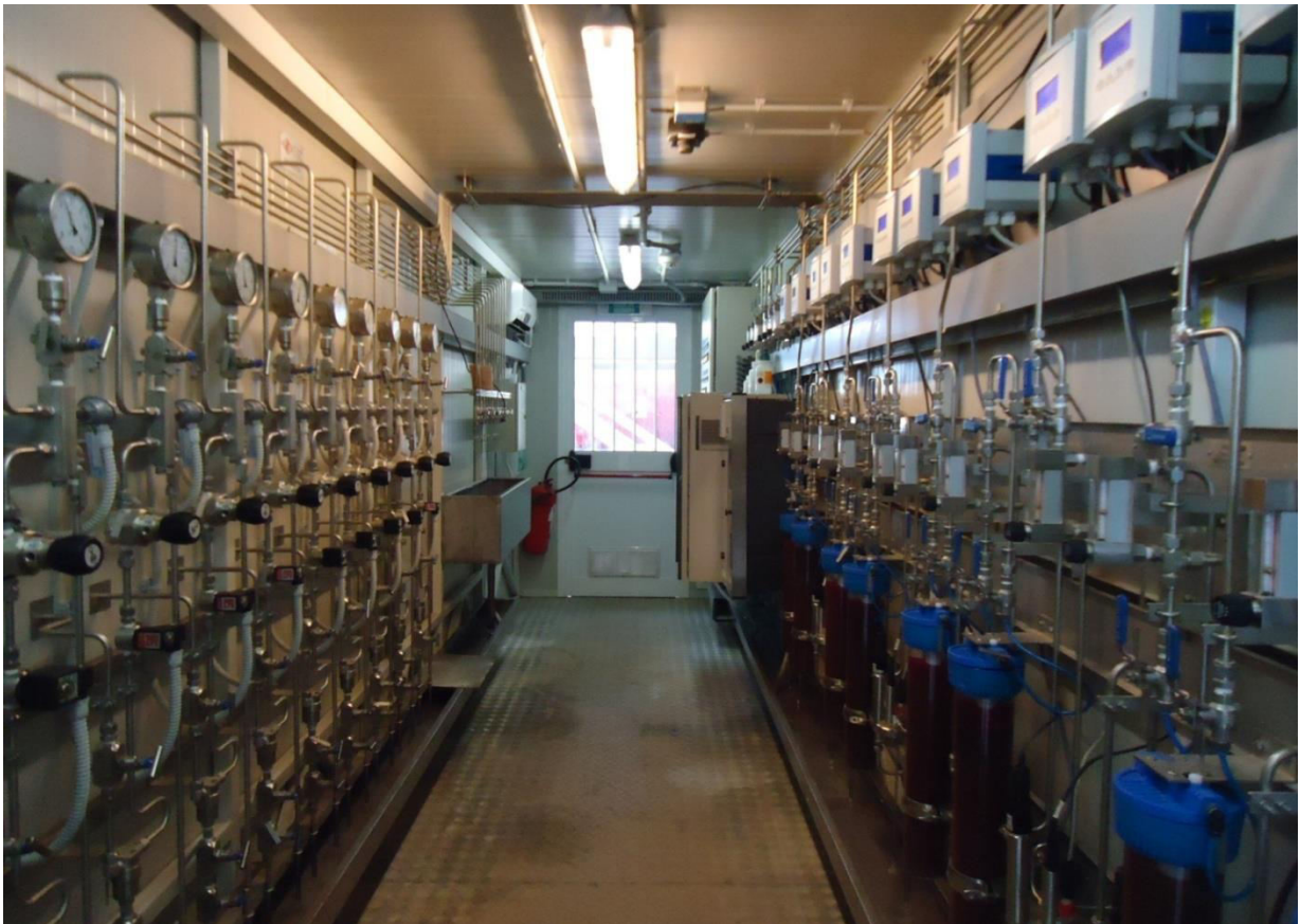
Figure 35 : Une unité d'injection d'ammoniac. [SKT]
