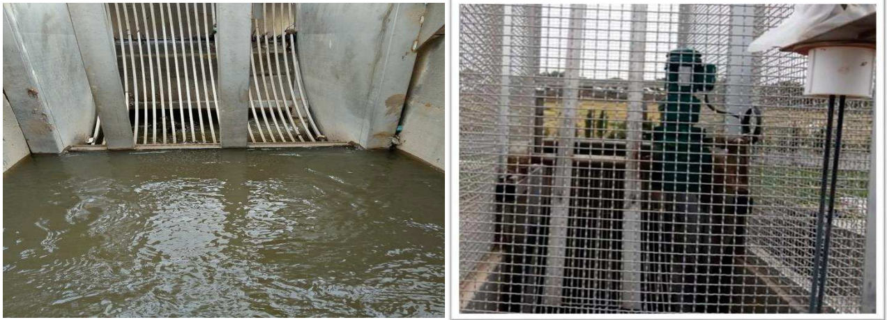
Figure VI: Dégrilleur courbe
