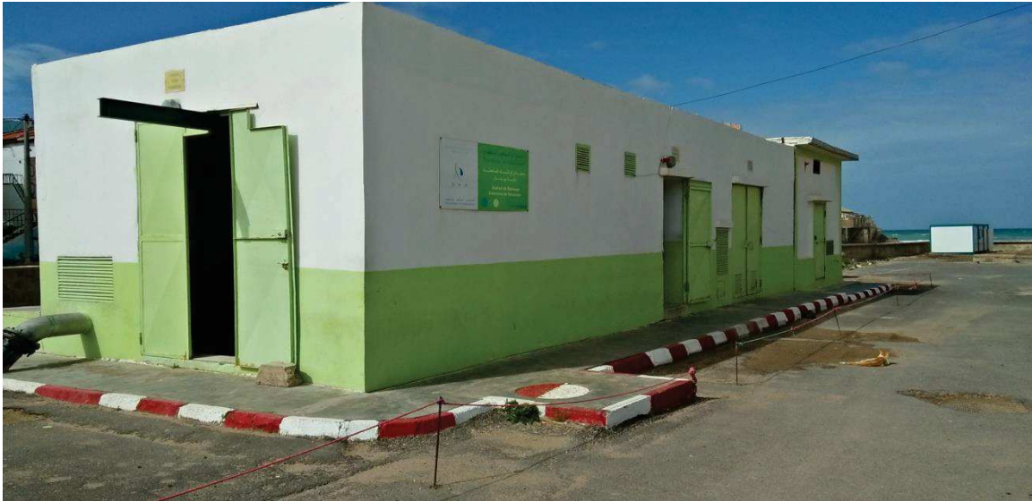
FIGURE III: Poste de relevage
