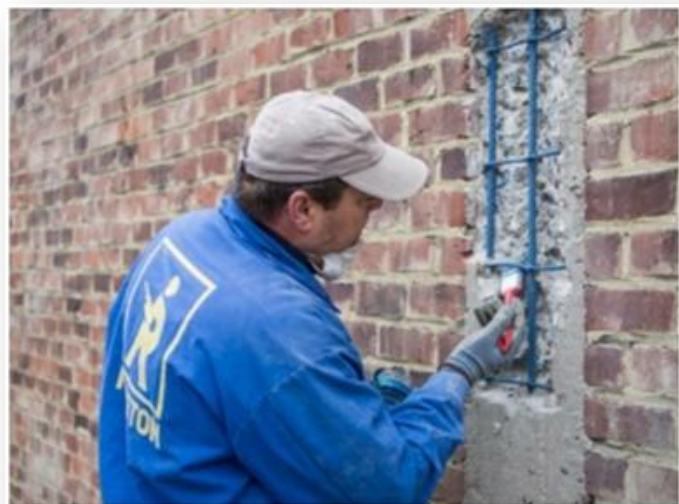
Figure n° 0.2 exemple de réparation
