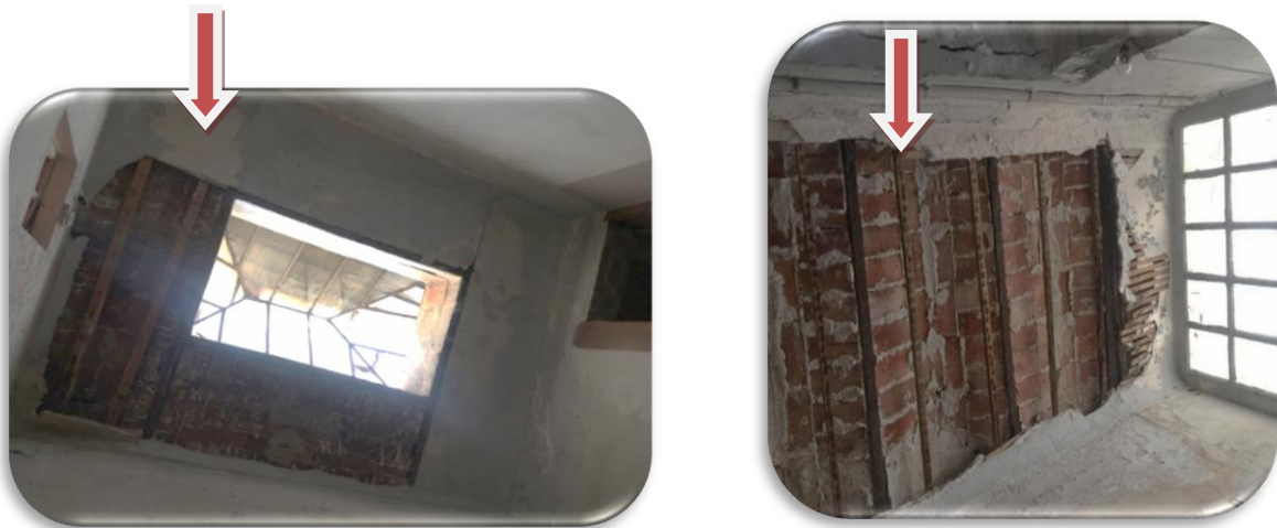
Photo n° 4.20 plafond de la cage d'escalier
