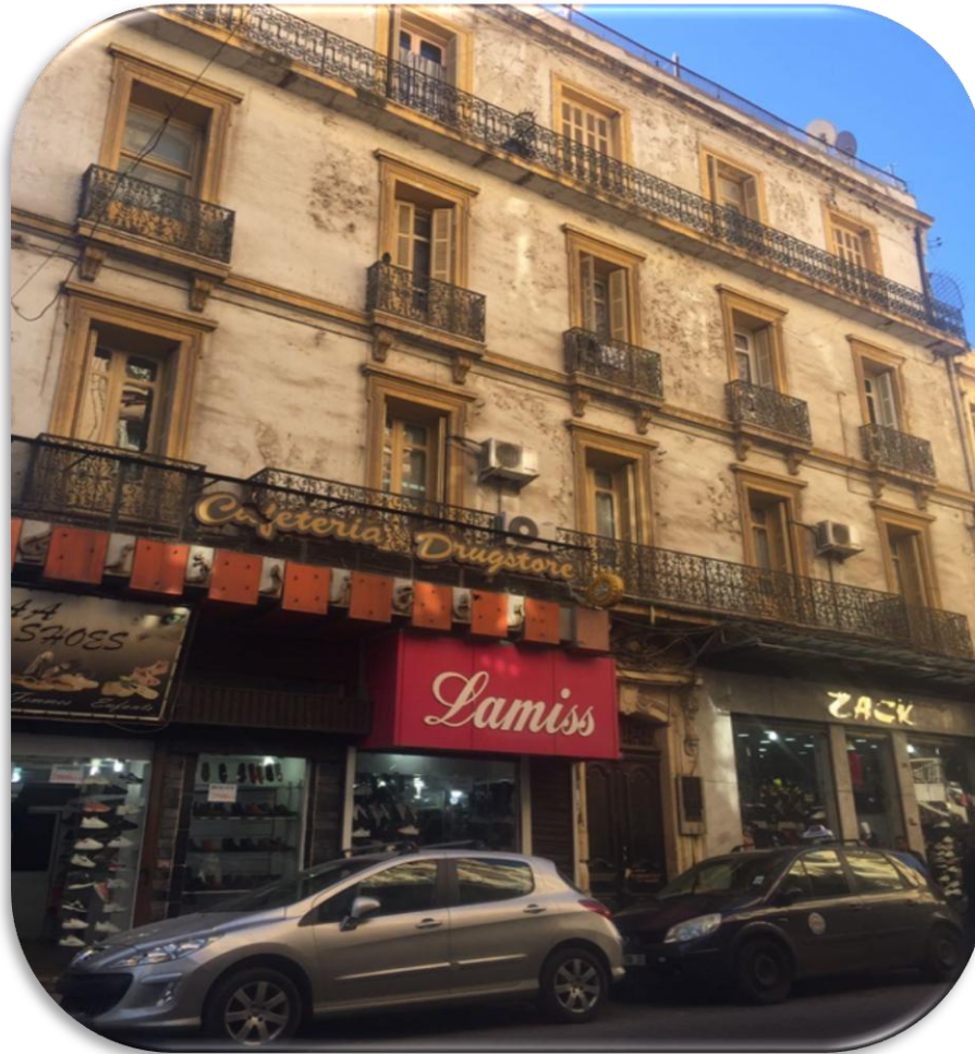
Photo n° 4. 59 : Vue de façade sur l'immeuble 26 boulevard l'arbi ben m'hidi
