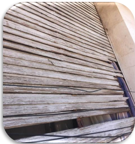
Photo n° 4. 94 : Traitement des éléments de menuiserie en bois
