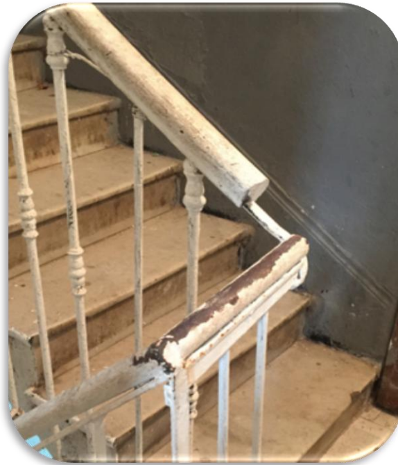
Photo n° 4. 100 : Réparation des balustres sur bardage garde-corps
