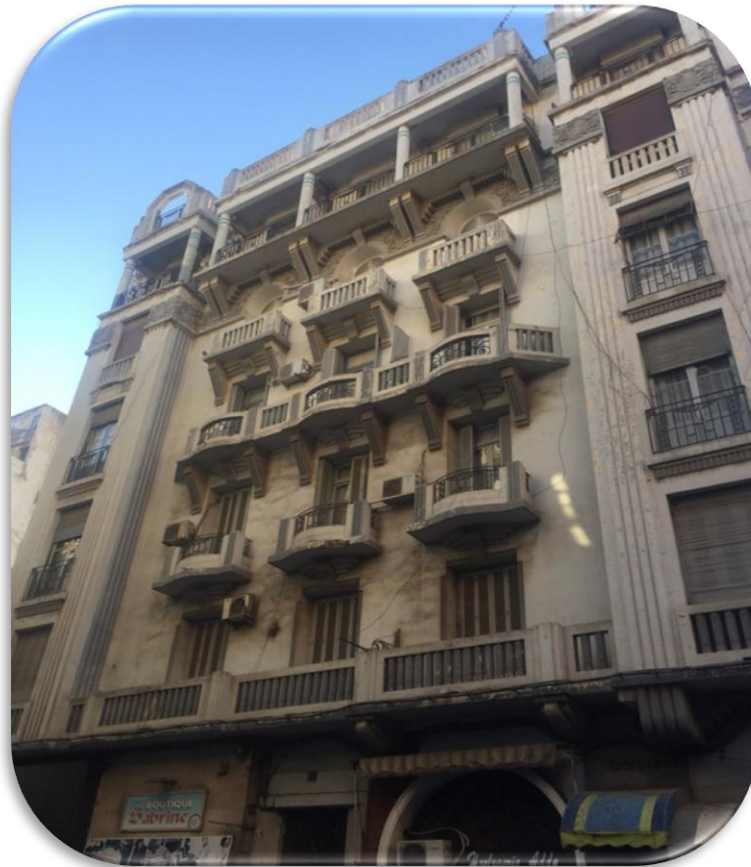
Photo n° 4. 36 : Vue de facade sur l'immeuble 28 boulevard l'arbi ben m'hidi Sources : Auteur
