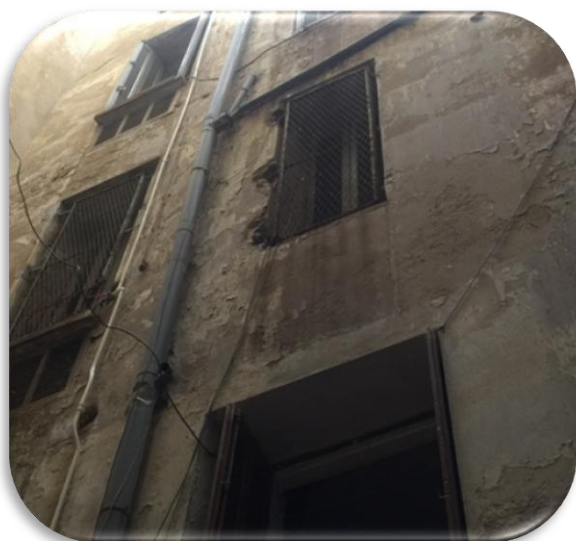
Photo n° 4. 57 Rajout de grillage au niveau des fenêtres
