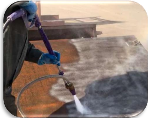
Photo n° 4. 89 : Travaux d'hydro lavage
