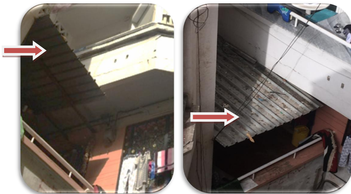
Photo n° 4.15 Rajout d'une couverture en tôle
