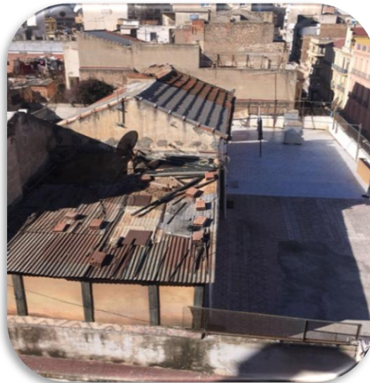
Photo n° 4. 76 : Un rajout d'une extension
