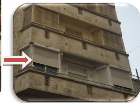
Photo n° 4.14 Remplacement des volet en bois par autre en PVC
