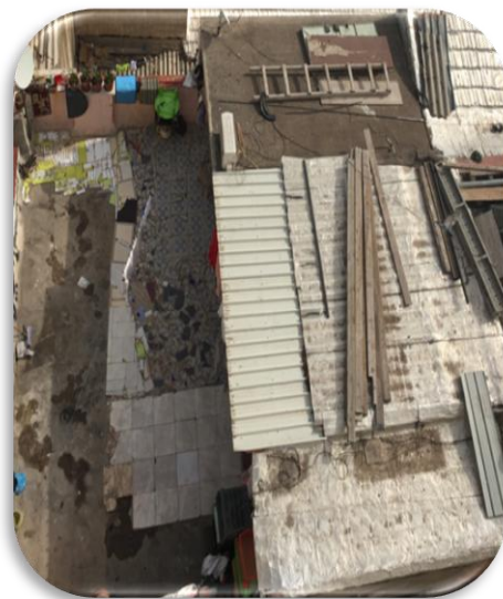
Photo n° 4.23 Un rajout d'un Extension sur la terrasse côté droit et gauche
