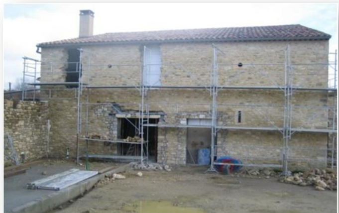
Figure n° 0 .1 exemple de réhabilitation
