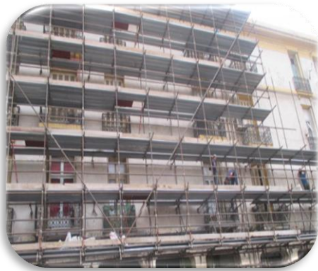
Photo n° 4. 88 : Installation de filet de protection
