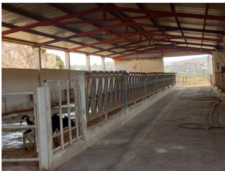
Figure 18 : Ventilation naturelle dans le bâtiment
