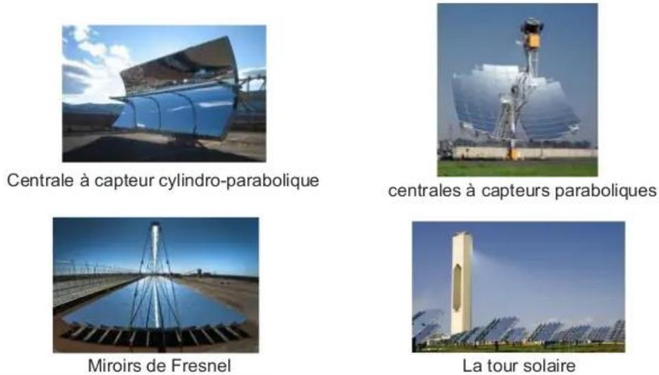
Figure I. 2: Les 4 principaux systèmes de concentration
