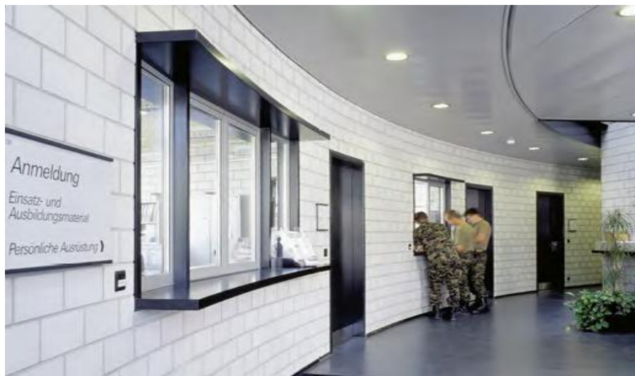
Figure 3 : Brique silico calcaire contre l incendie
