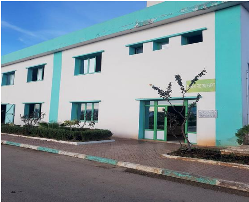
Figure III.3: Bâtiment de prétraitement de la STEP.
