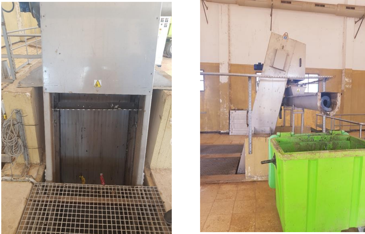
Figure III.6: Grille mécanisé grossie.
