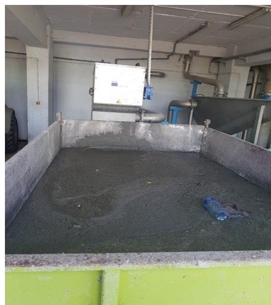
Figure III.12: Evacuation des sables et des huiles.
