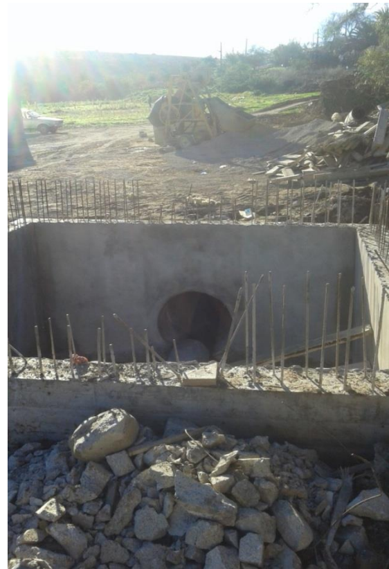
Figure II.7 : Déversoir en cours de réalisation
