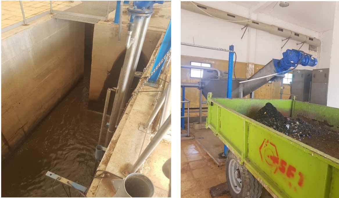
Figure III.7: Piège à sable.
