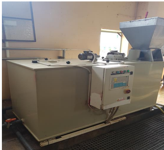
Figure III.22: Préparation du polymère.
