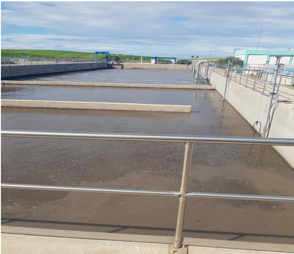
Figure III.13: Bassin d'aération.
