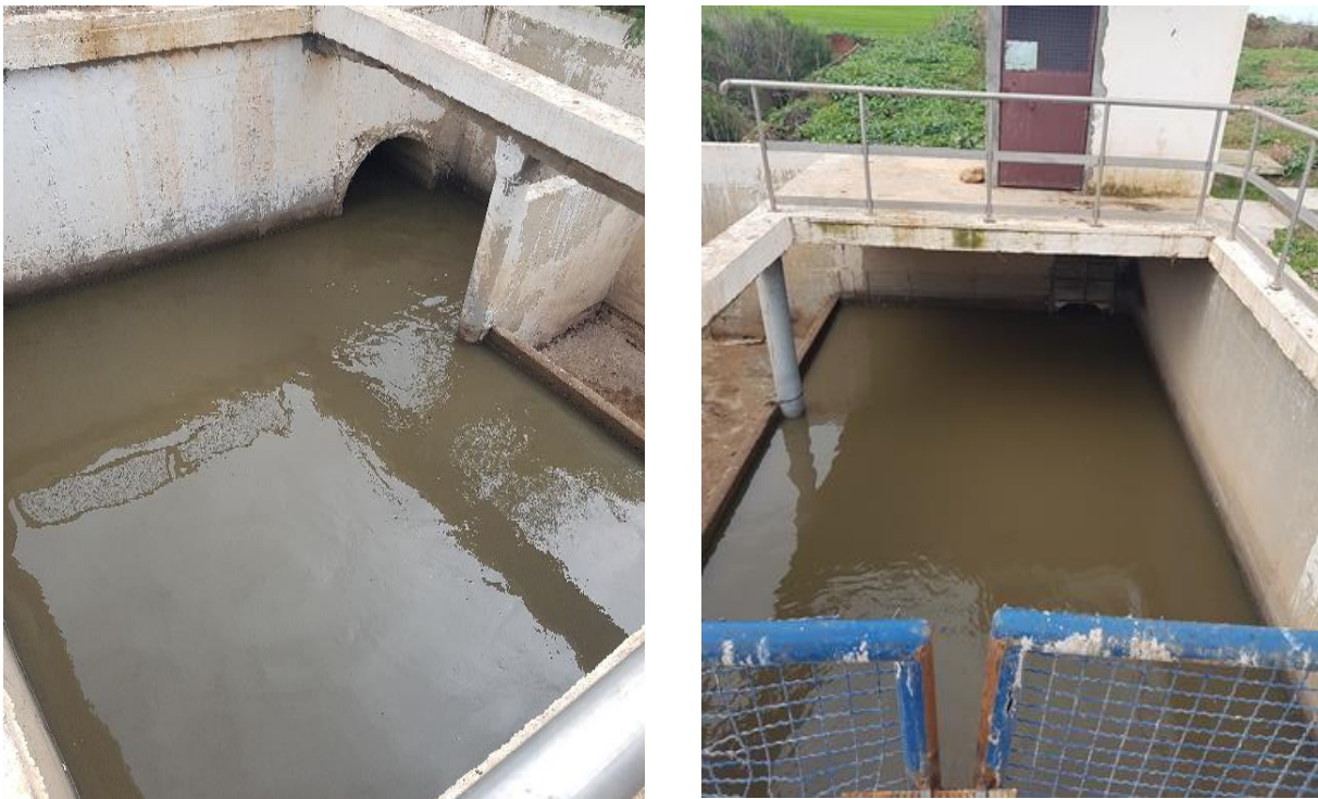
Figure III.2: Déversoir d'orage.
