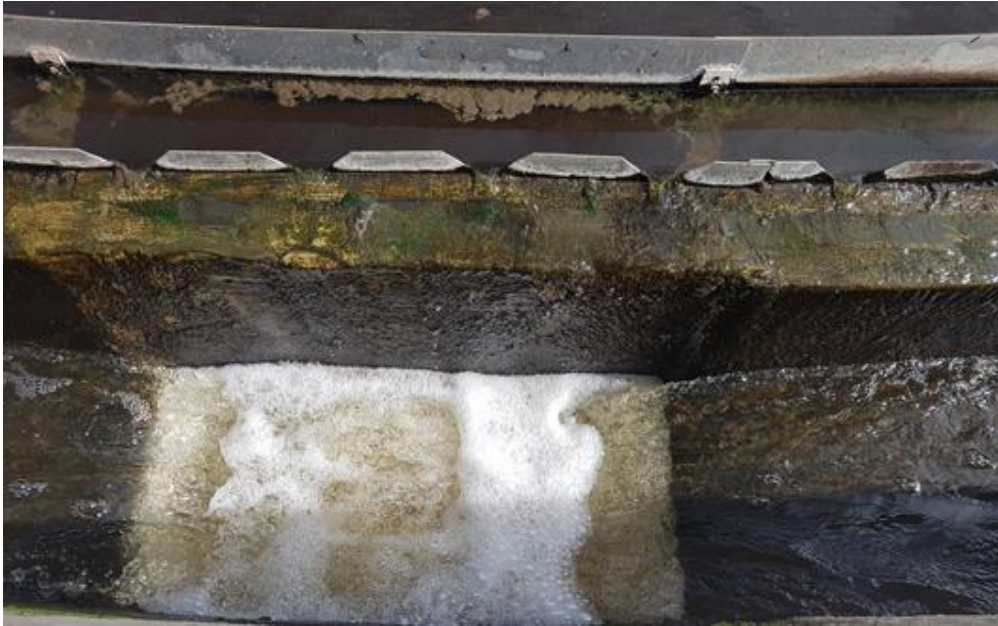
Figure III.15: Eaux traitées à la sortie du déversoir du clarificateur.
