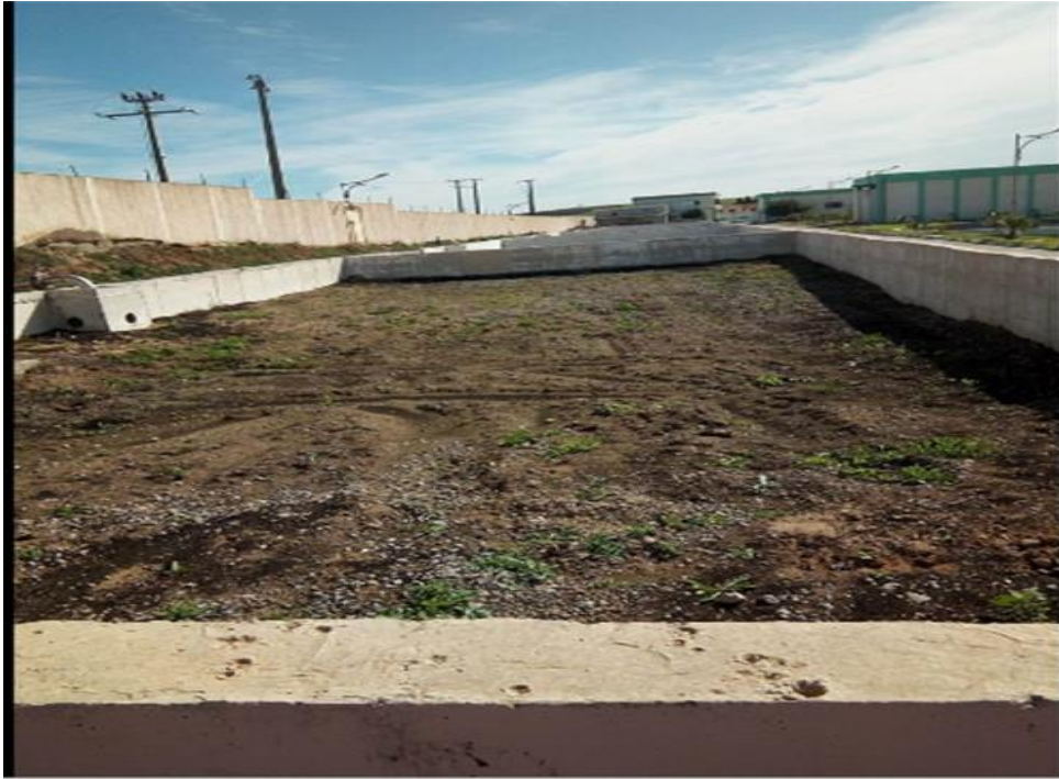
Figure III.20: Lit de séchage (période d'hiver)
