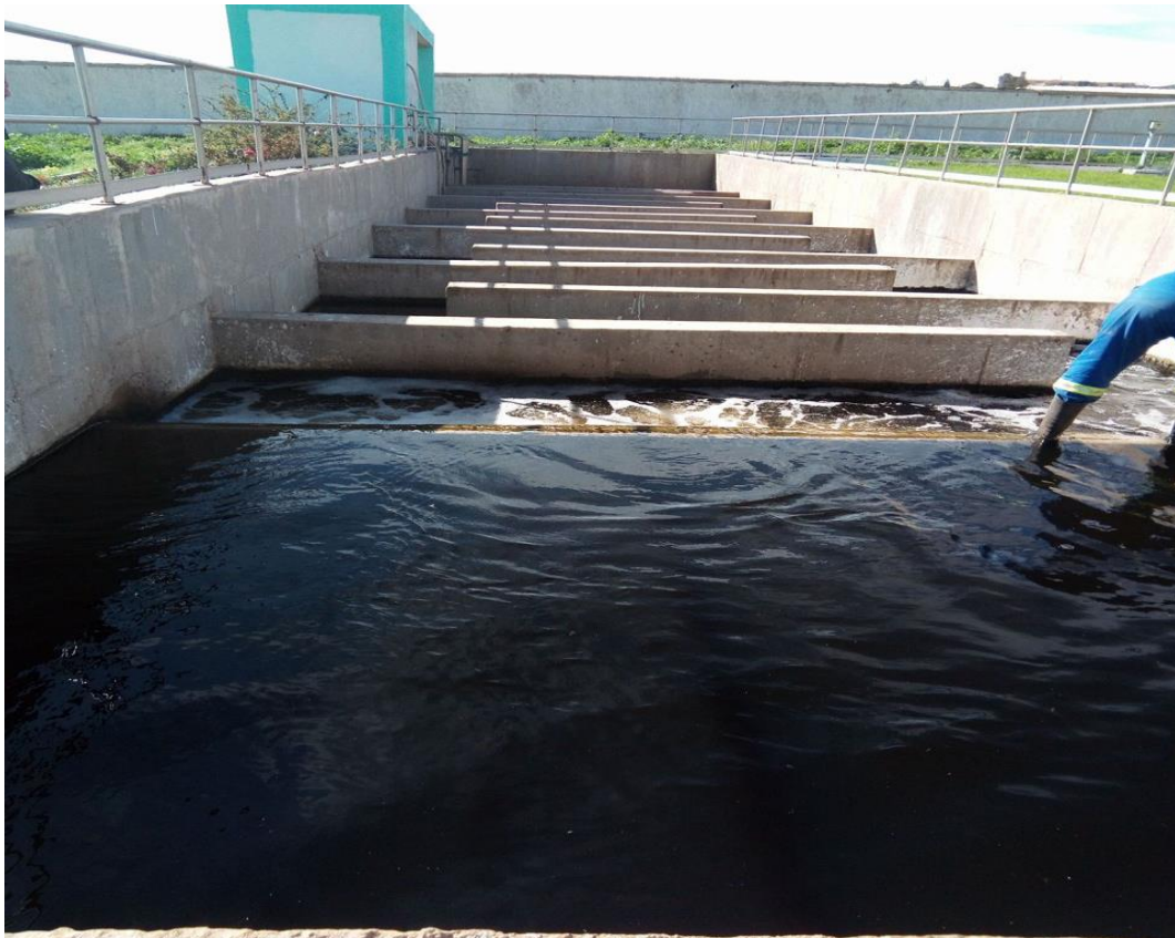
Figure III.17: Bassin de désinfection.
