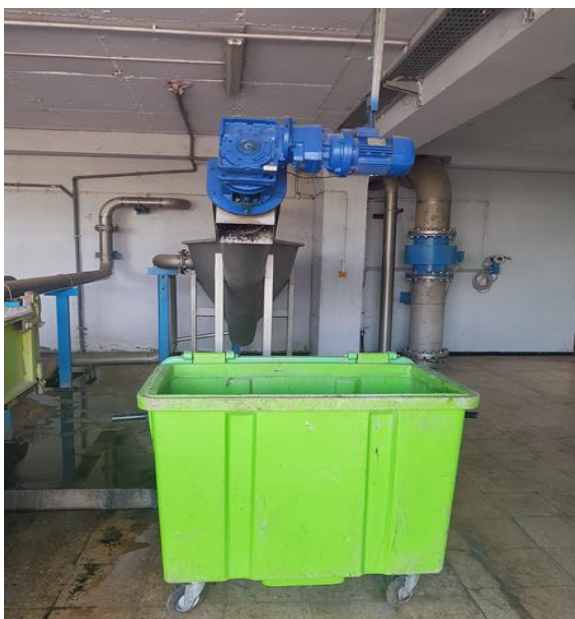
Figure III.12: Evacuation des sables et des huiles.
