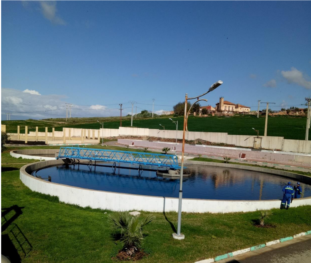
Figure III.14: Décanteur secondaire.
