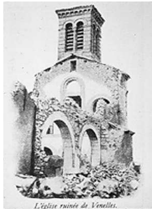
Eglise sur sol meuble
