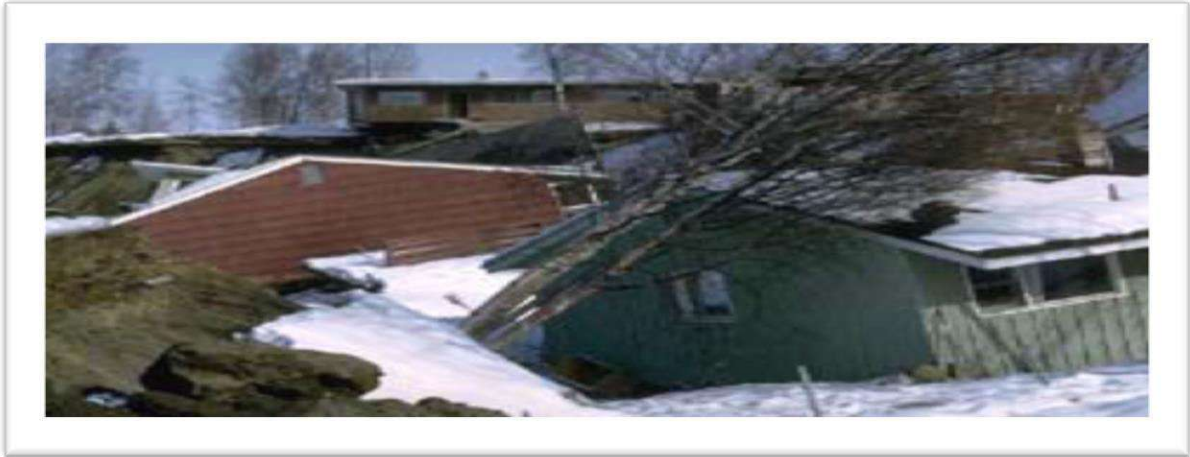
Figure 2.18. Maisons en bois non effondrées malgré un important glissement de terrain, séisme d'Anchorage, Alaska 1940.
