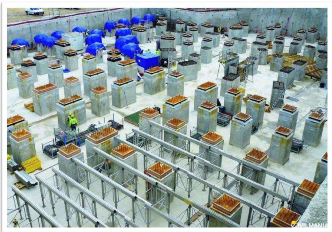
Figure 4.1. Position des appuis parasismiques dans un bâtiment.
