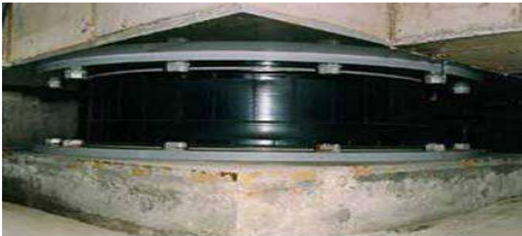
Figure4.7. Appuis en élastomère à fort taux d'amortissement
