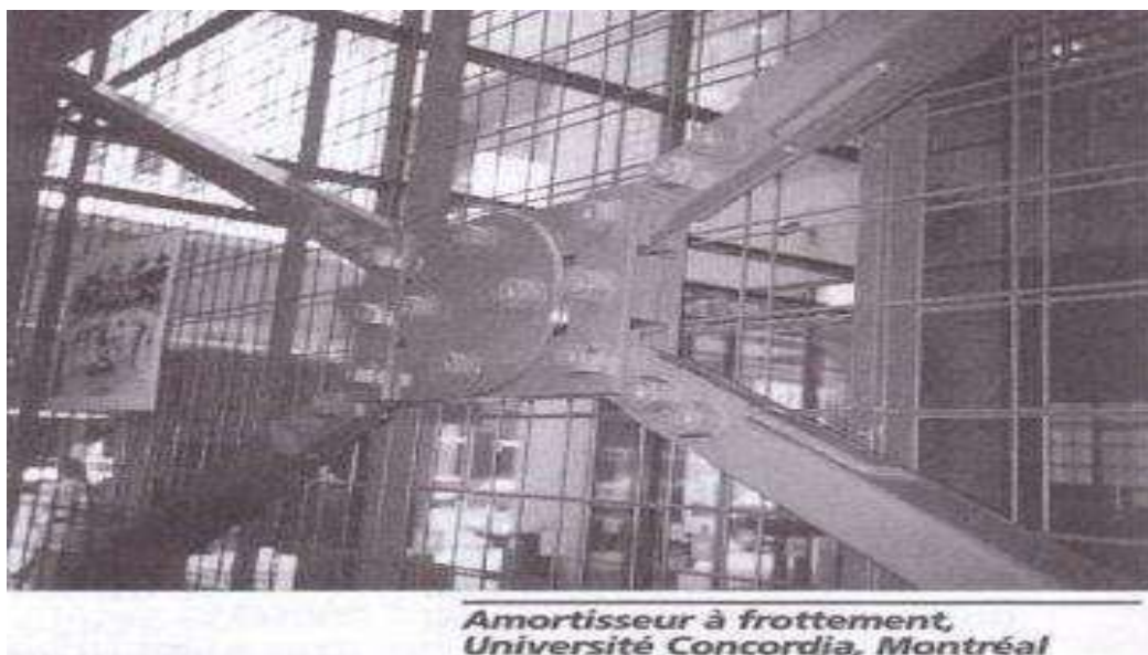
Figure 4.18. Amortisseur à friction.
