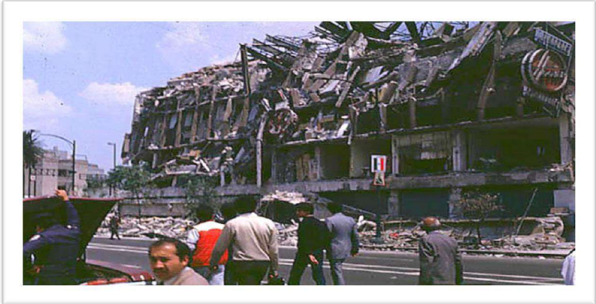
Figure 2.4. Dommages sismiques dus à la résonance du bâtiment avec le sol.
