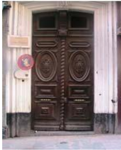
Figure I.5 Ancien portes en bois
