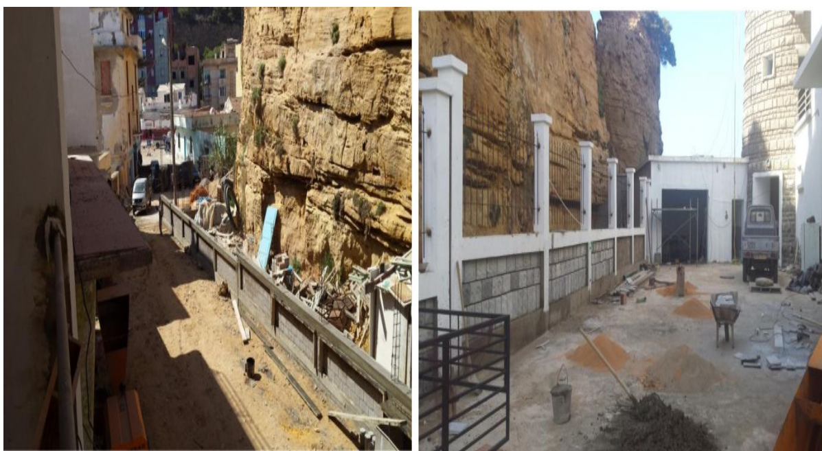
Figure I.34 : Travaux d'aménagements de la voie d'entrée principal
