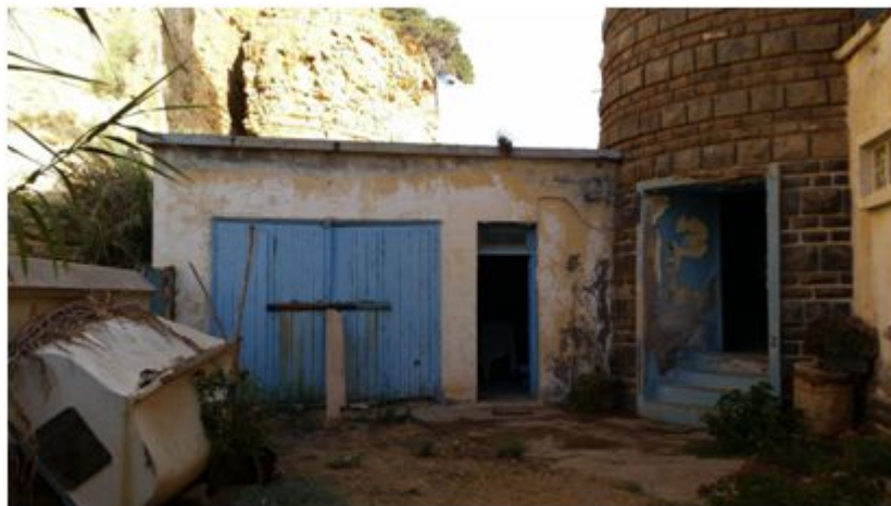
Figure I.8 : L'entrée de château d'eau
