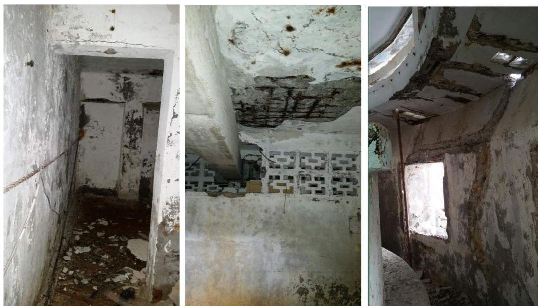
Figure I.16 : Derrière les bassins aux rez-de-chaussée
