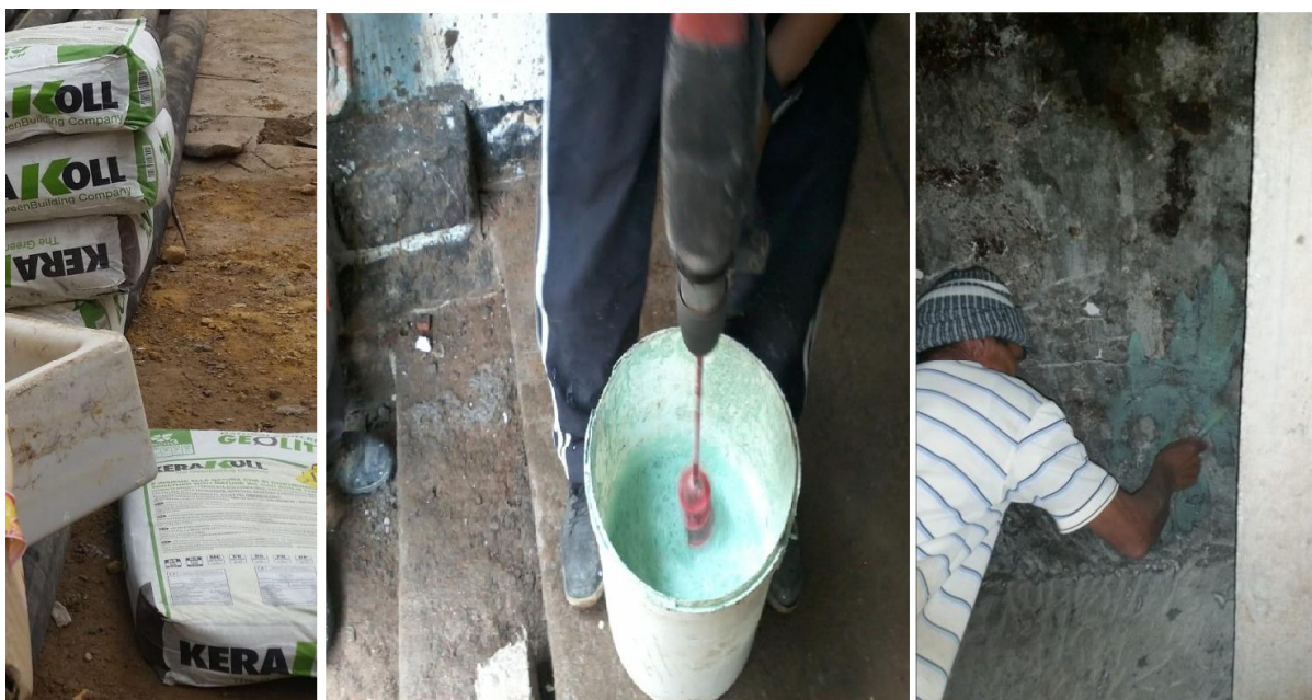
Figure I.40 :l'utilisation d'enduit kerakoll
