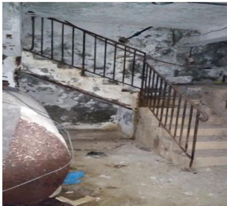
Figure I.11 : Escalier du sous-sol
