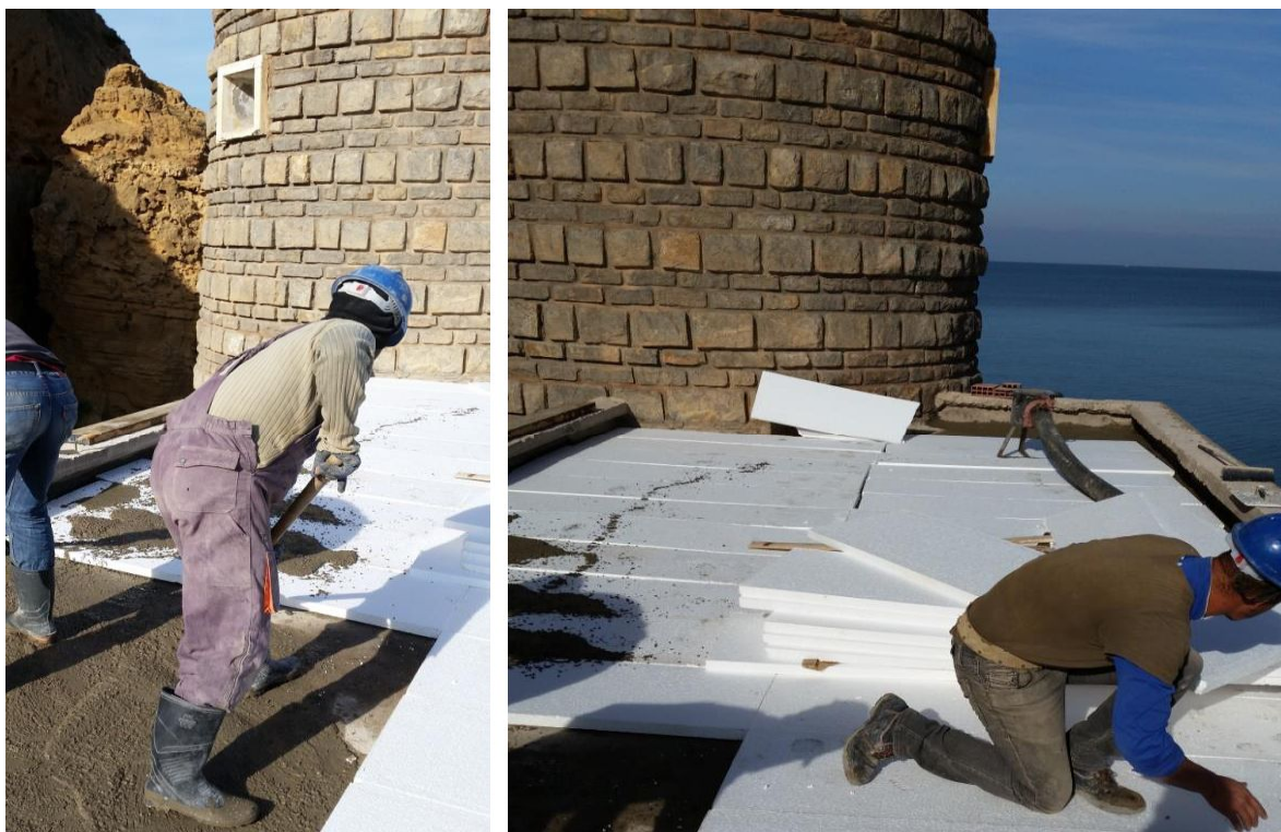
Figure I.43 Rénovation complète d'étanchéité de la terrasse.
