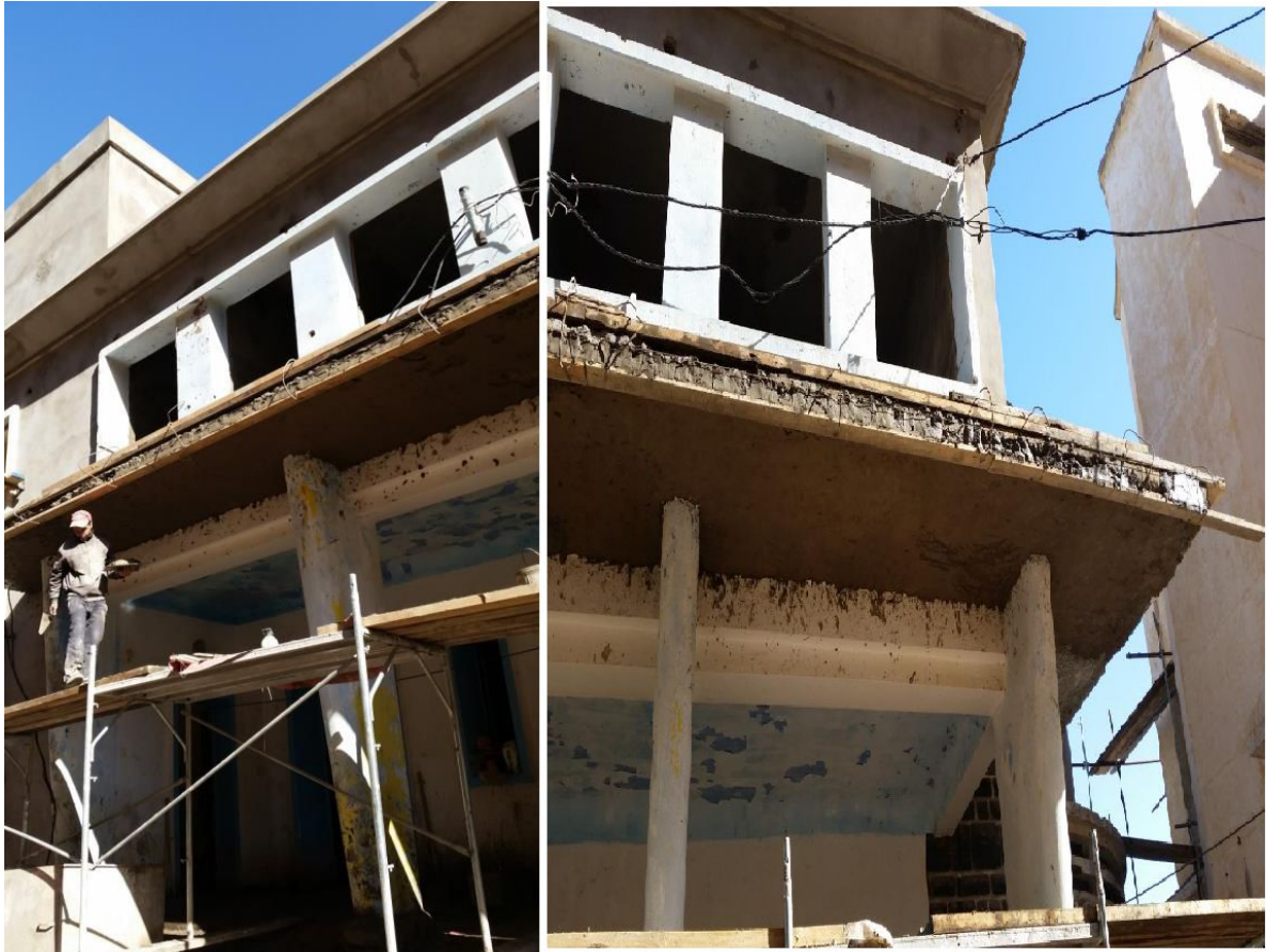
Figure I.35 :Réparation des balcons en béton.
