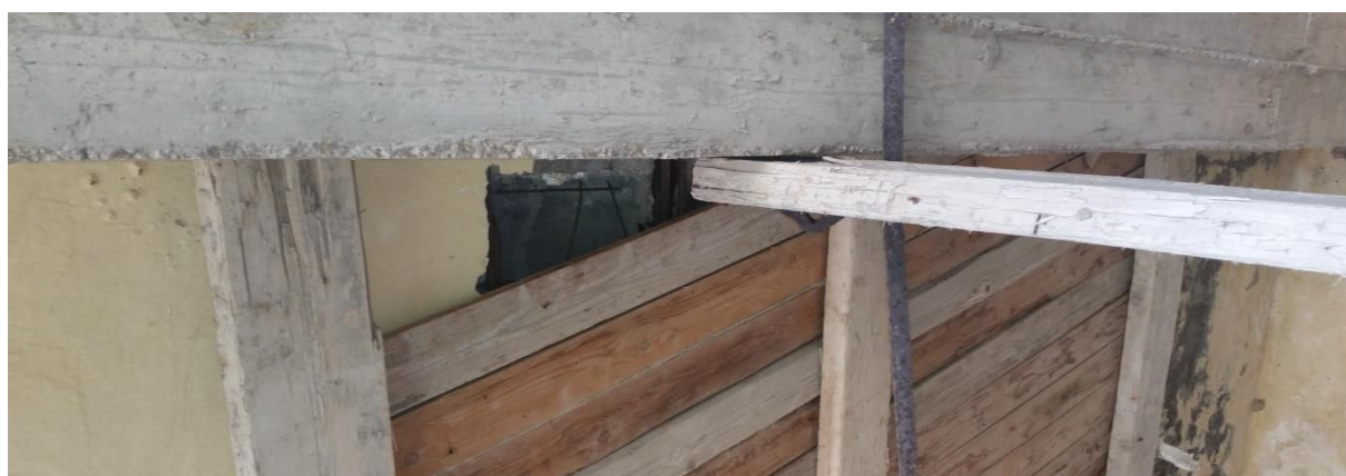
Figure I.39 : Renforcement des bassins par un voile.
