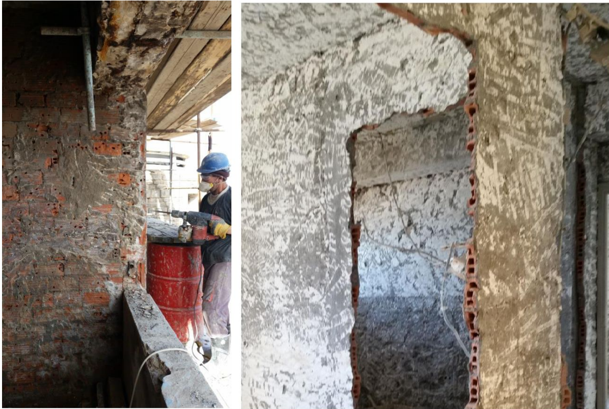
Figure I.37 : Décapage des cloisons d'intérieurs
