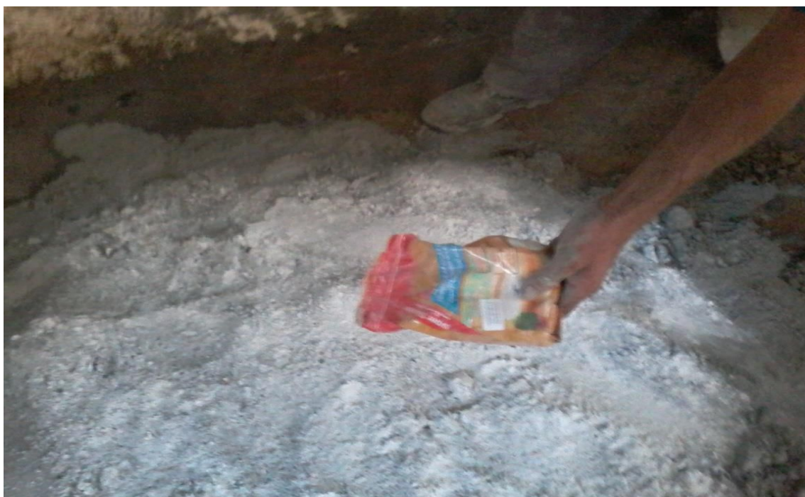
Figure I.42 :L'utilisation des adjuvants dans le mortier.
