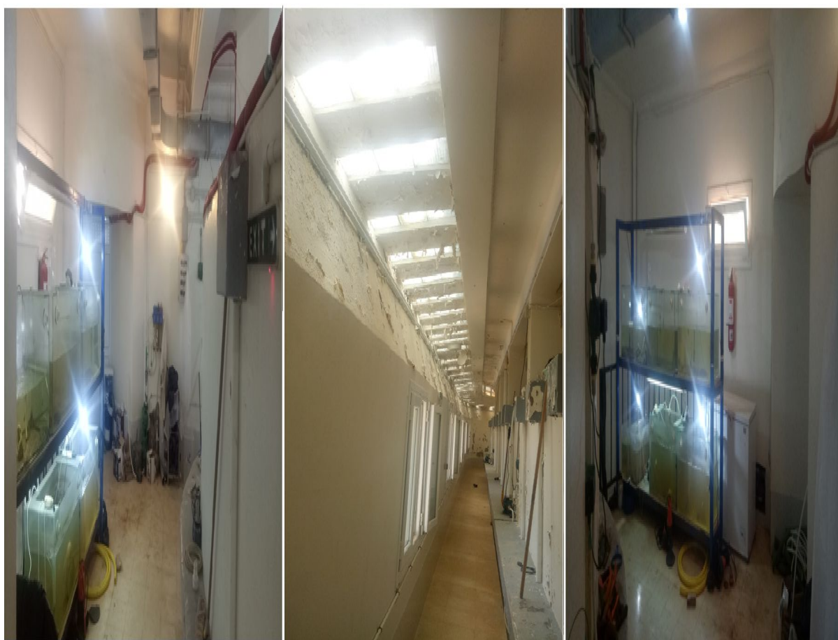
Figure I.54 : Couloirs derrière les bassins au rez-de-chaussée
