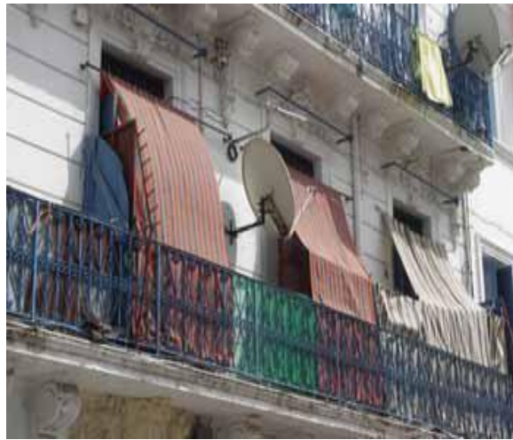
Figure I.2 Bâtiment: balcons filants (la Kasbah d'Alger)
