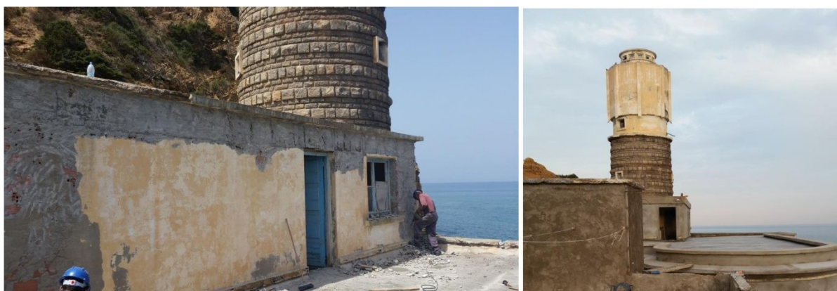
Figure I.44 : La terrasse pendant et après la rénovation.
