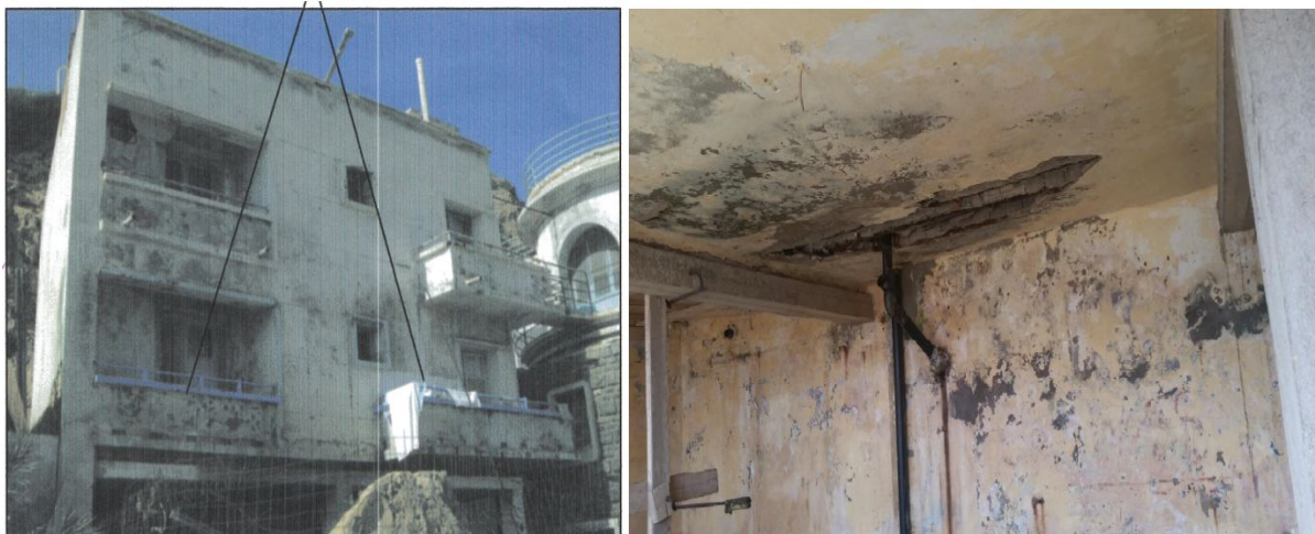
Figure I.20 : Logement de fonction
