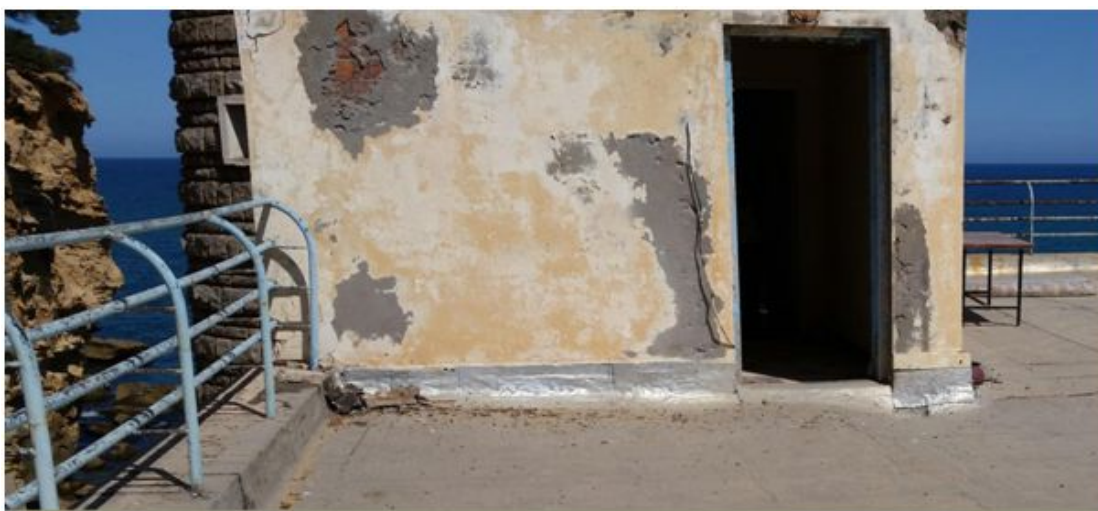
Figure I.9 : Cage d'escalier de la terrasse.
