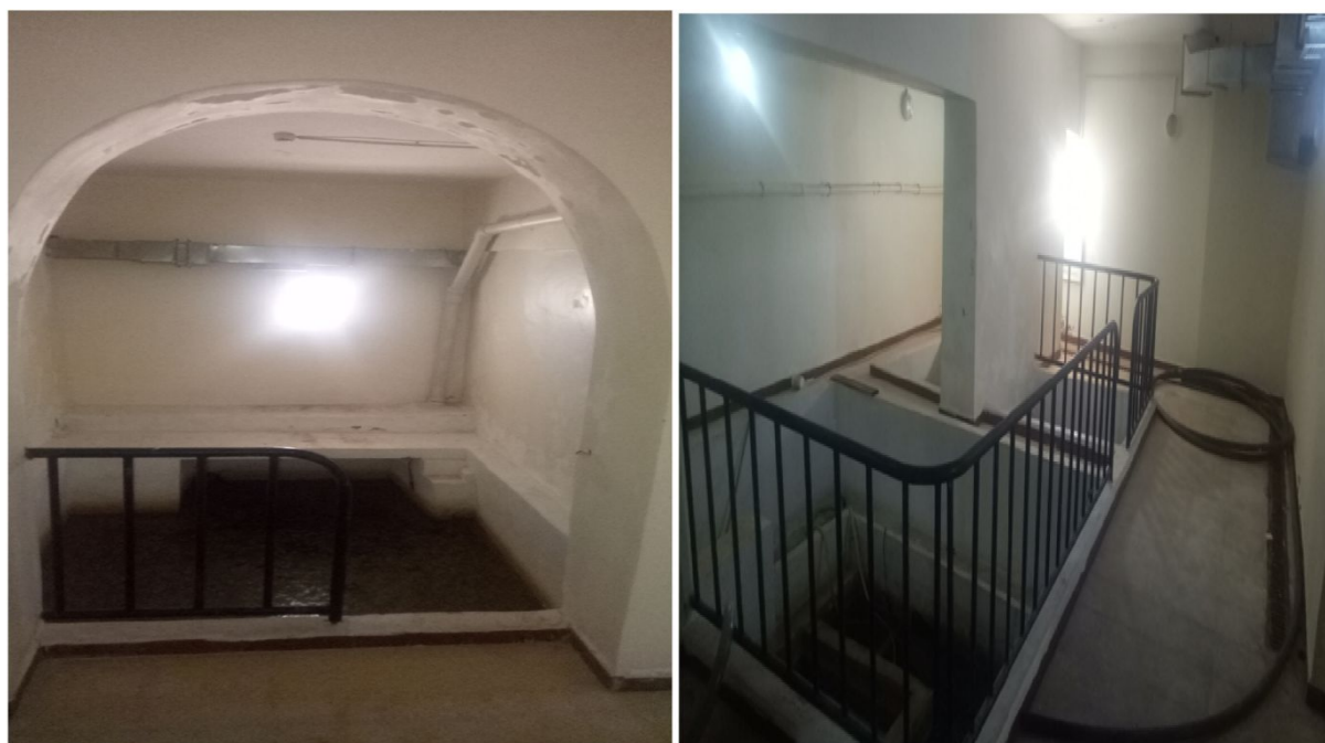
Figure I.51: Bâches à eau (douces et eau de mer).
