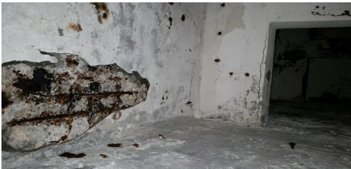
Figure I.13 : Mur à l'intérieur du sous-sol
