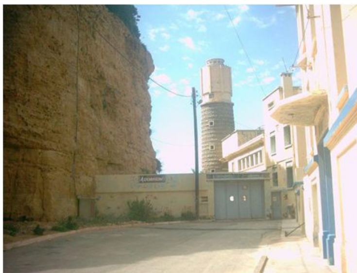
Figure I.6 : L'entrée principale de l'aquarium avant réhabilitation
