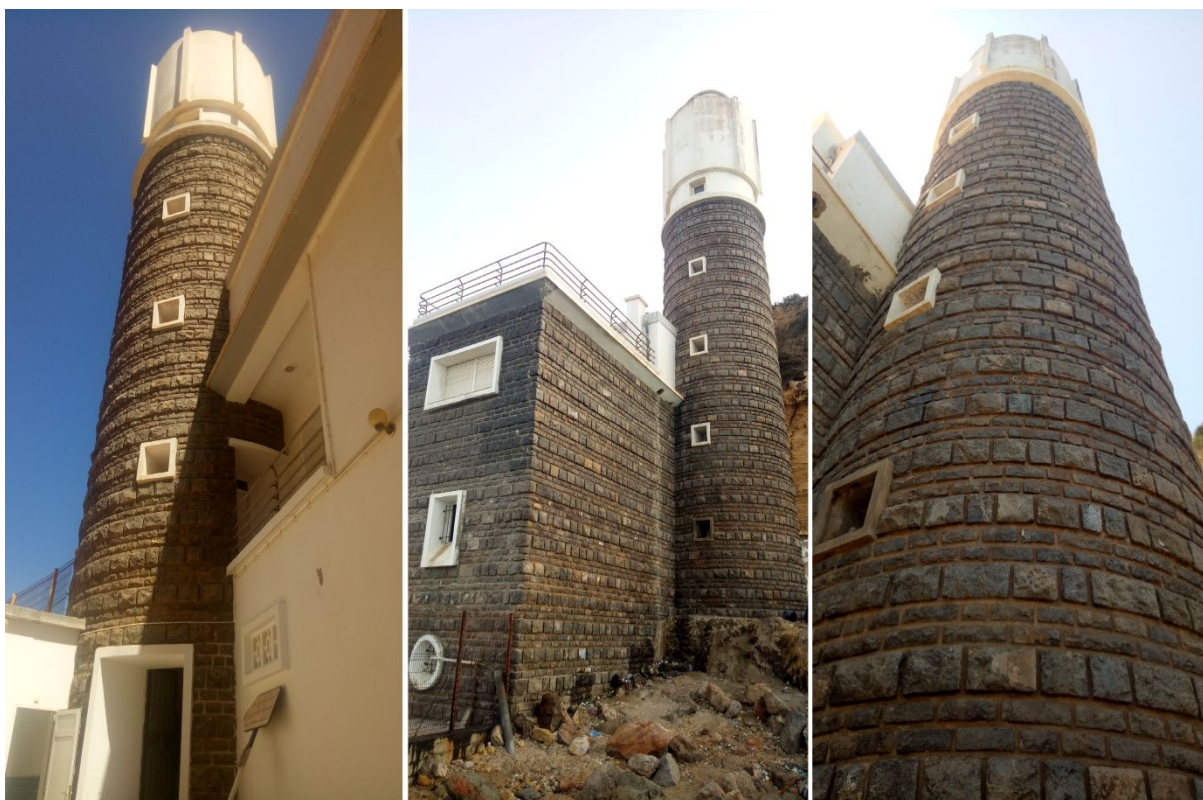
Figure I.48 : La tour de l'aquarium (château d'eau).
