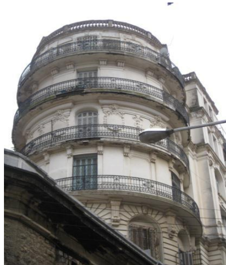
Figure I.13: Ancien bâtiment (fori circulaire)
