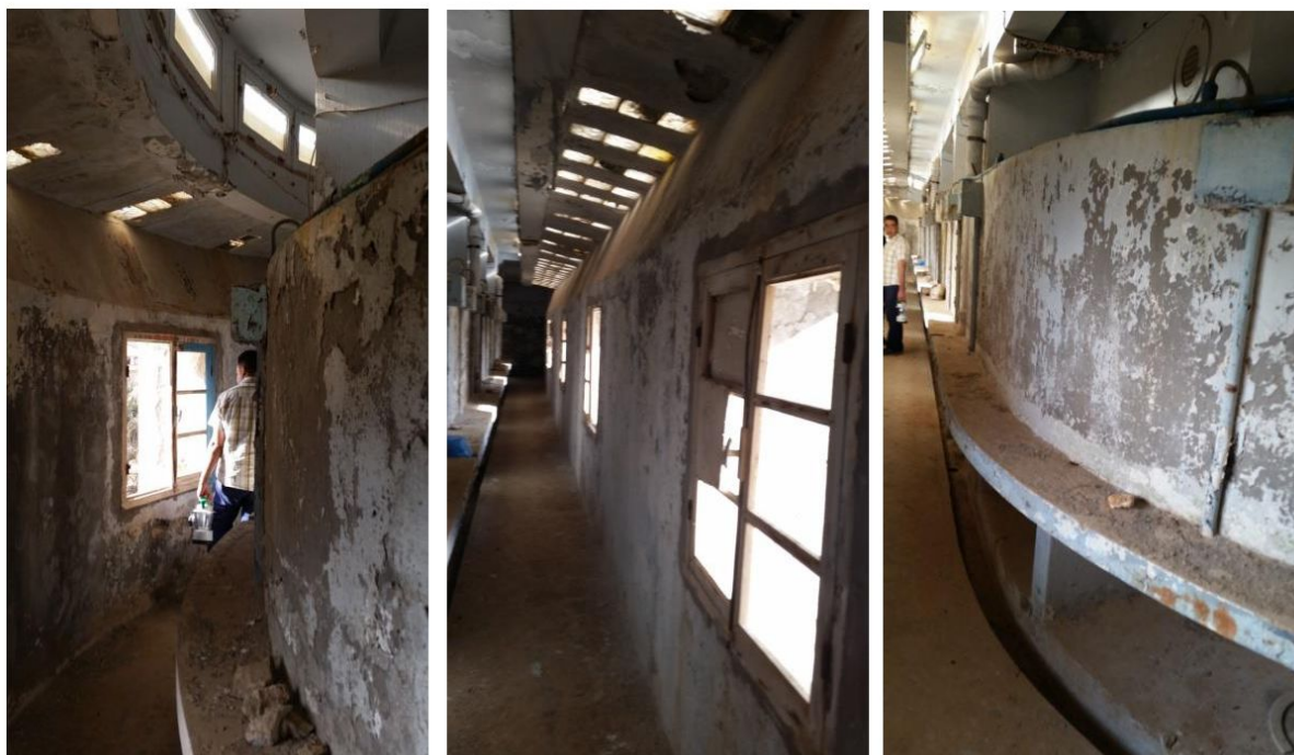
Figure I.17 : Couloirs derrière les bassins au rez-de-chaussée
