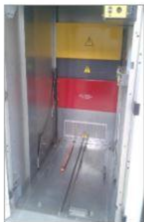
Figure I-9: Compartiment disjoncteur
