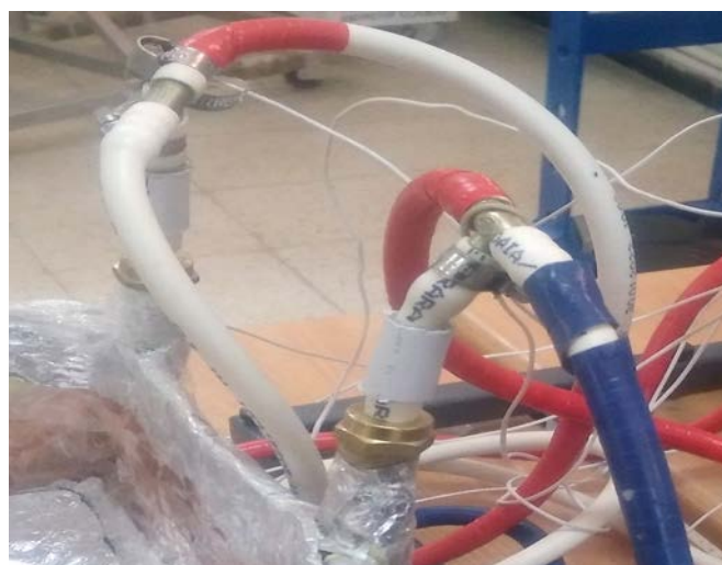
Figure 3.7 : Raccord by-passe pour l'entrée et la sortie du serpentin
