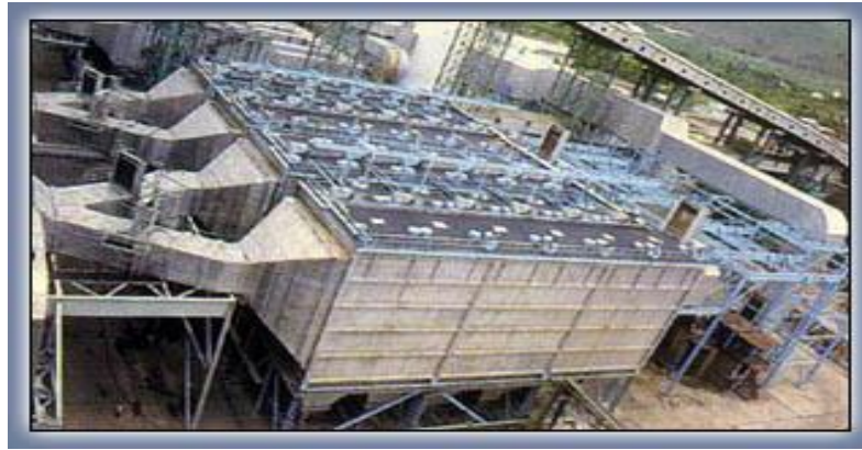
Figure(II.1) : Photographie d'un précipitateur électrostatique.
