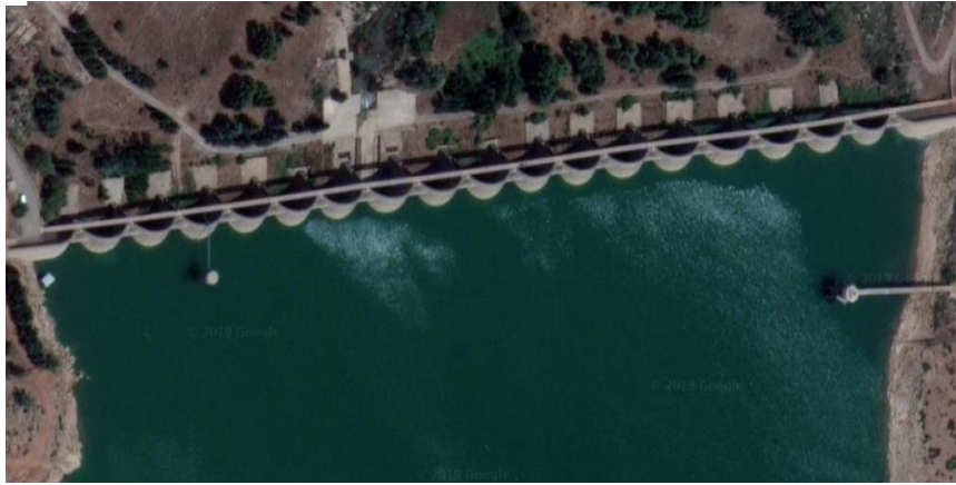
Image 3.3 : vue aérienne du corps de barrage à voûte multiples
