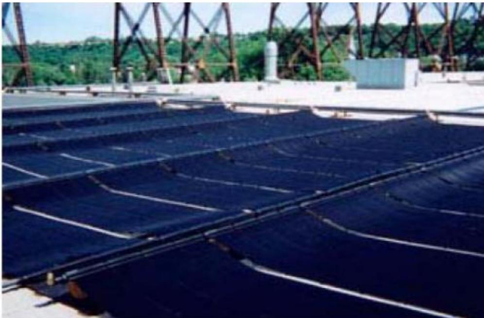
*Figure I.24 : Capteur plan non-vitré.*
