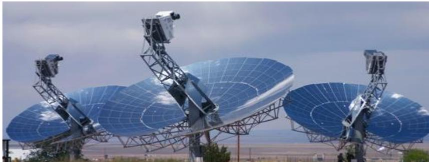
Figure I.19 : Capteur parabolique.
