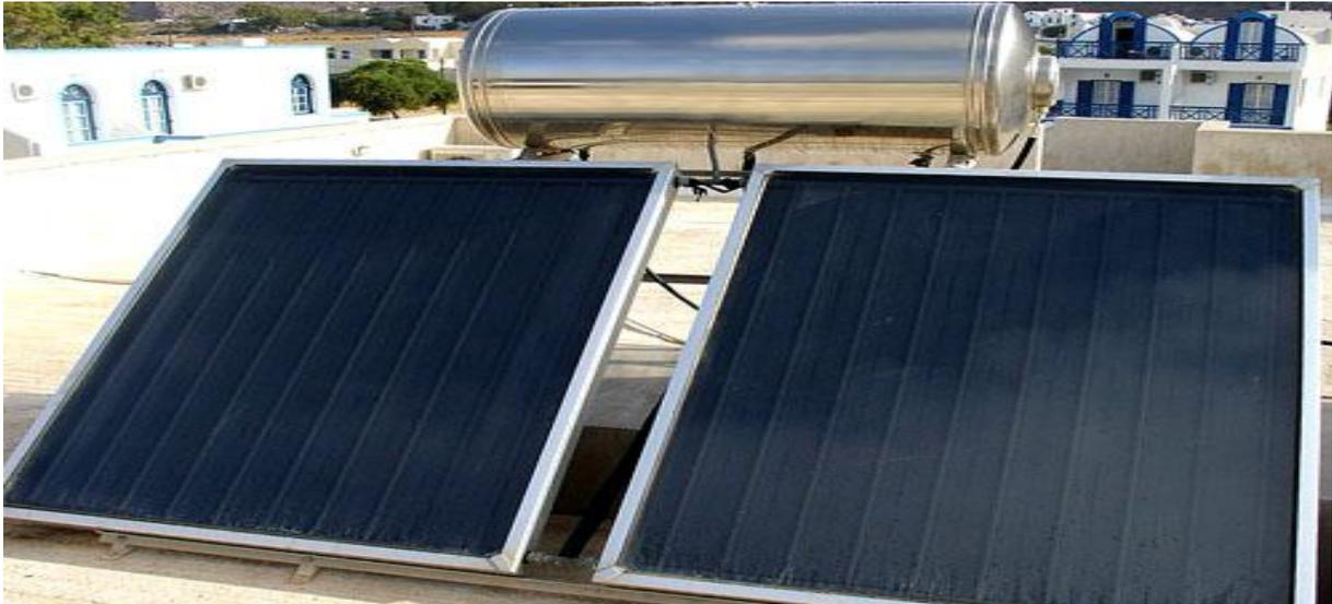
*Figure 1.23 : Capteur plan.*
