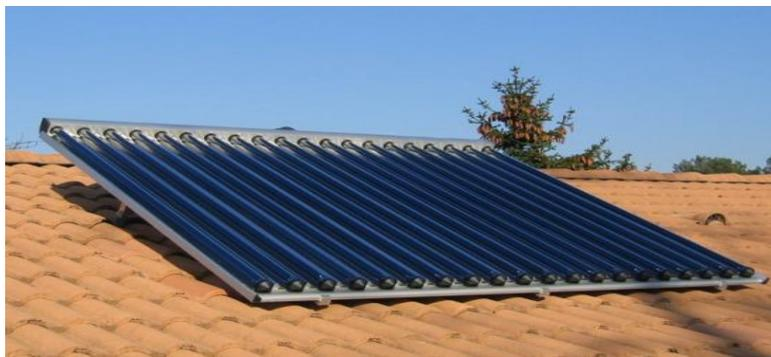
*Figure I.21 : Capteur à tubes sous vide.*
