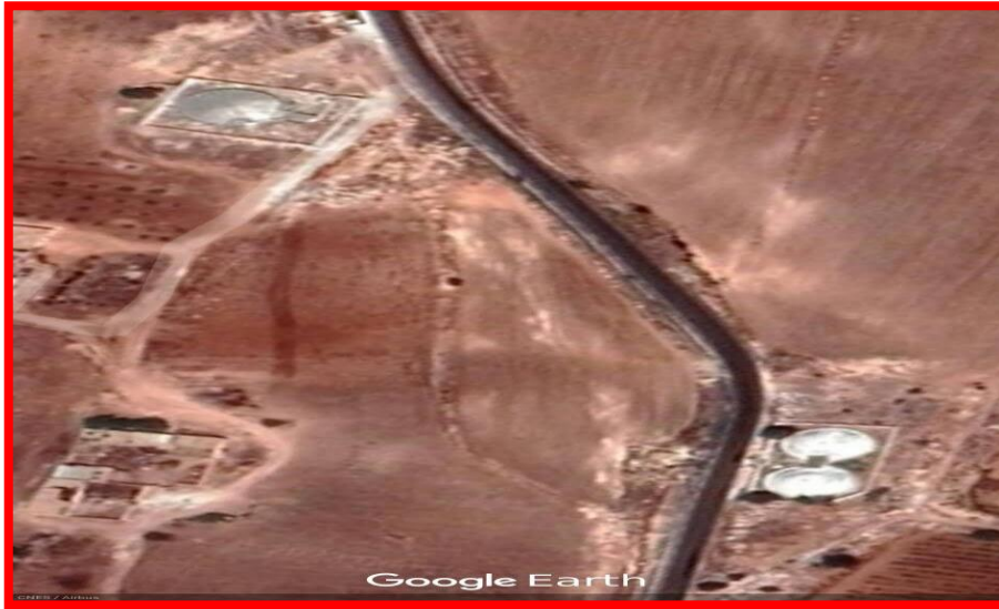
Figure 14 Réservoir de stockage Amria
