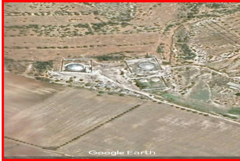
Figure 16 Réservoir de stockage Hassi el Ghella
