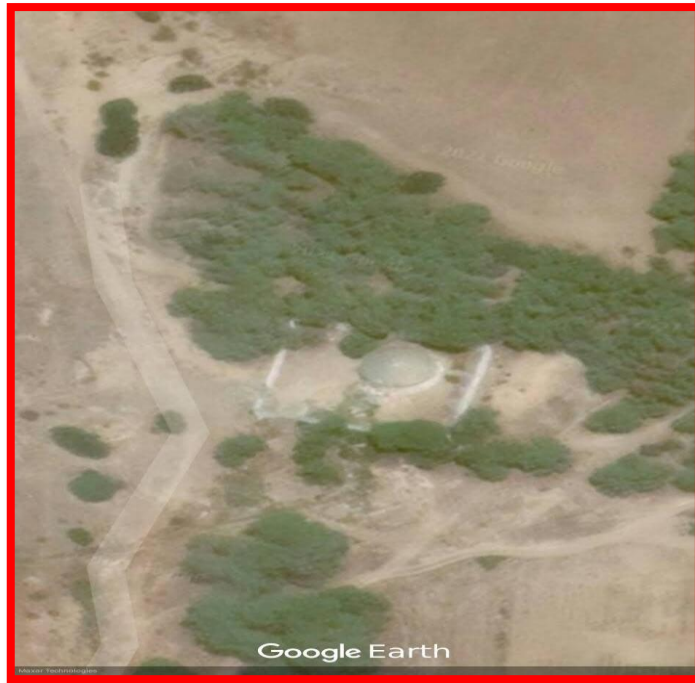
Figure 22 Réservoir de stockage Ouled Boudjema
