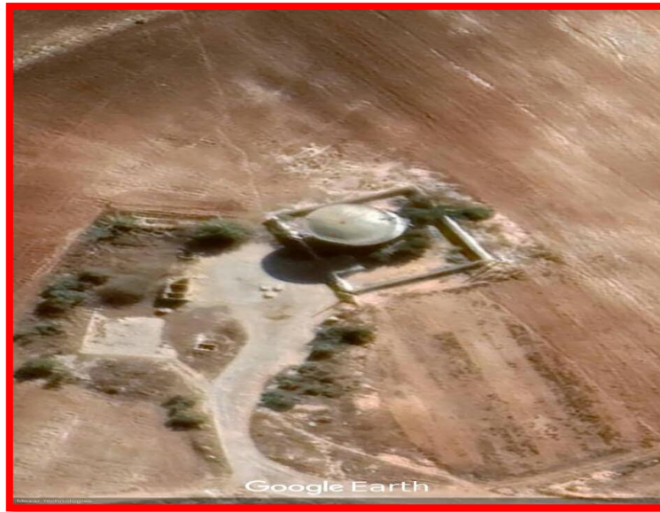
Figure 18 Réservoir de stockage M'said
