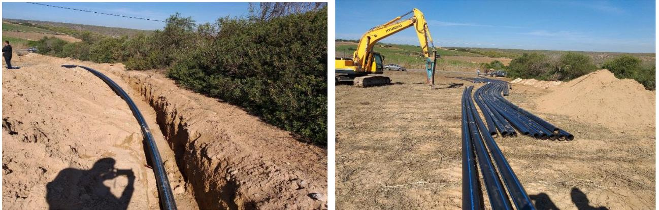
**Figure III.9 : Exemple des travaux de mise en place d'une conduite d'adduction en PEHD**
