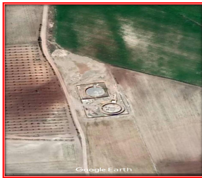
Figure 9 : Réservoirs Jumelles 2*1000 M3
