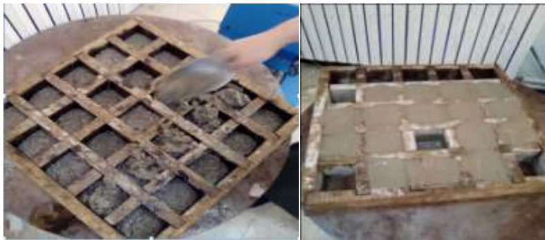
Figure 29. La mise en place du béton.
