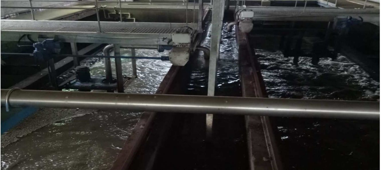
Figure N°6 : Déssableur –Dégraisseur
