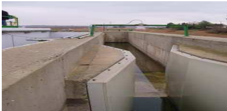
Figure N°4 : Débitmètre Venturi
