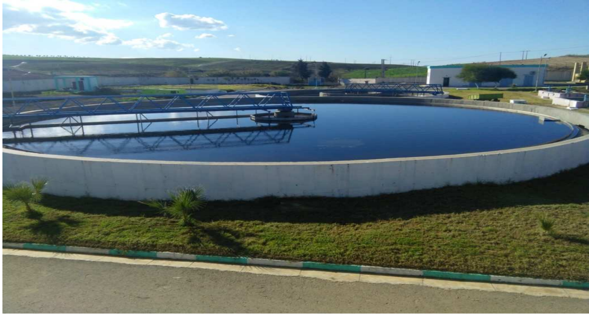
Figure N° 8 : Décanteur secondaire
