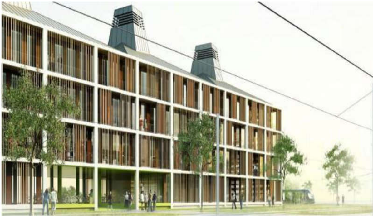
Figure I.13 : Cheminées solaire de l'immeuble Michelin à Bordeaux. [11]
