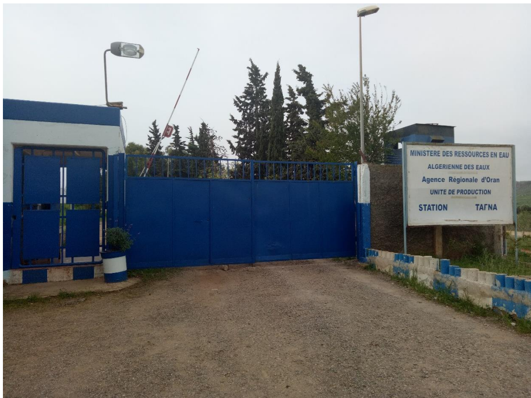
Figure II.1 : La station de prétraitement Tafna.
