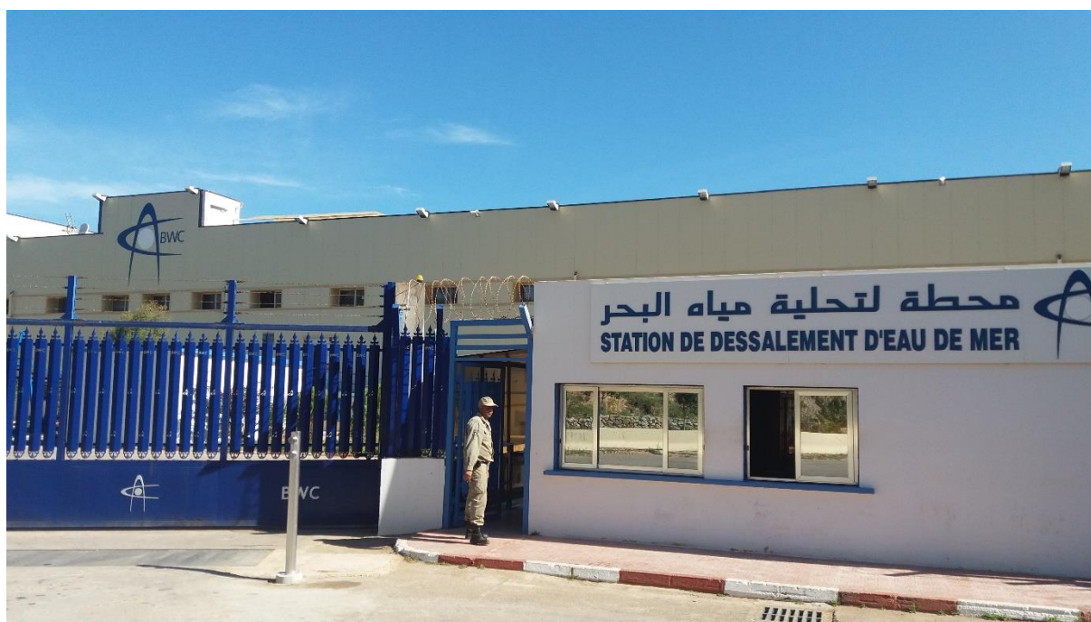
Figure II.5 : la station de dessalement des eaux de mer BWC
