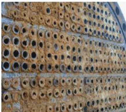
Figure I.23: échangeur sale et propre [18]
