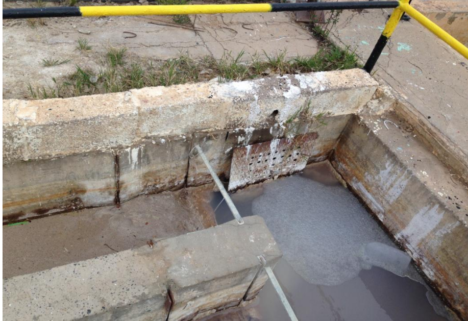
Figure 6 : Déversoir d'orage
