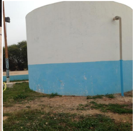
Figure 14 : Réservoir d'eau décantée
