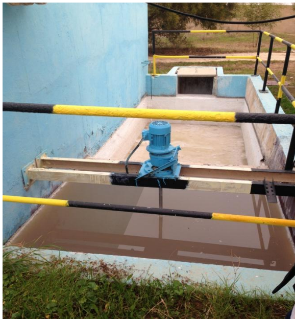
Figure 16 : Clari-floculateur
