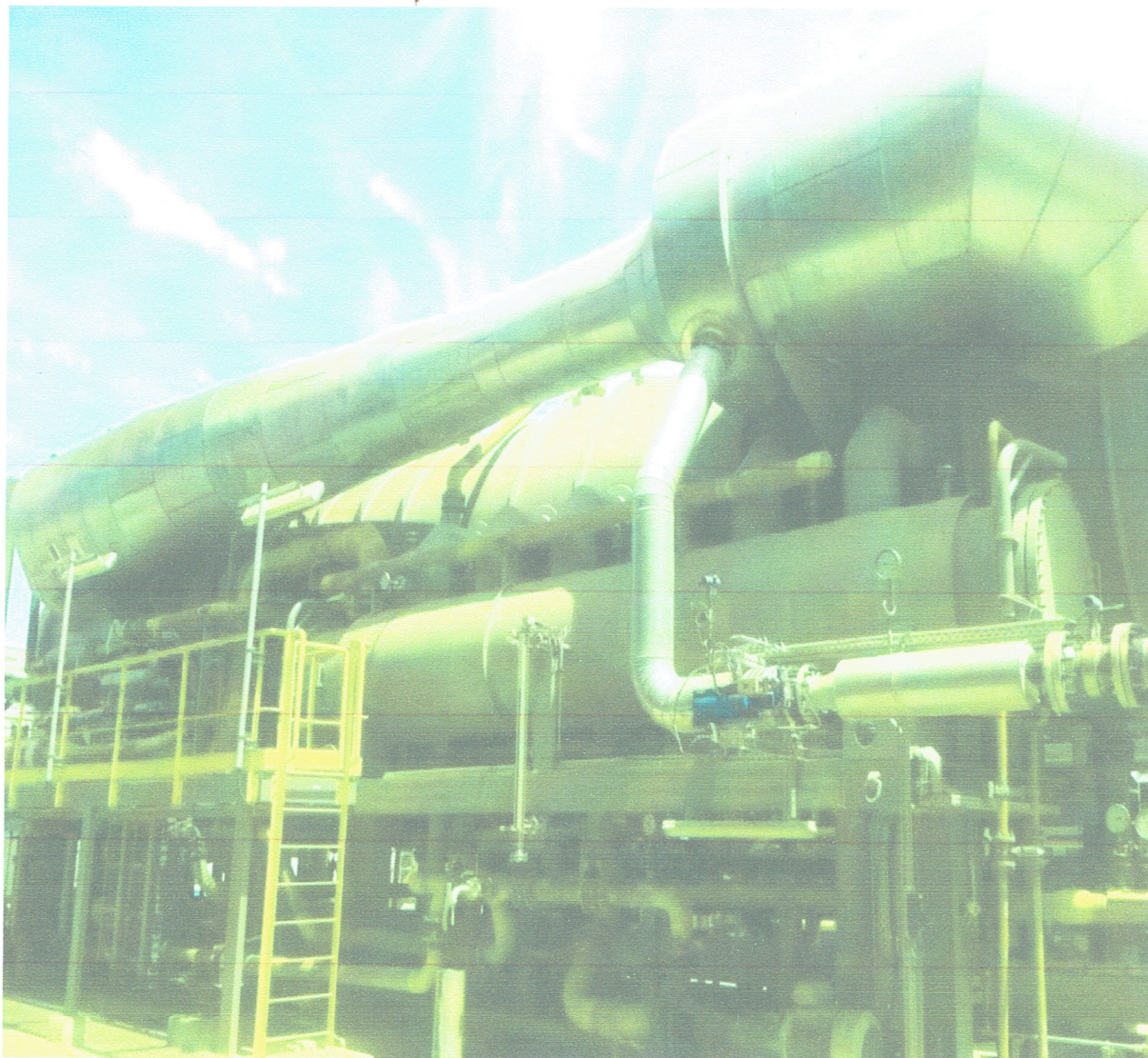
Figure II.11 : Procédé de dessalement à thermo compression U.510
