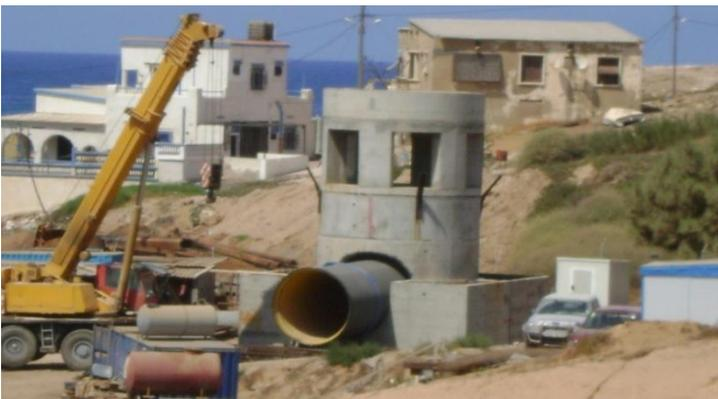
Figure IV- 2: Préfabrication de la tour de Captage. [47]
