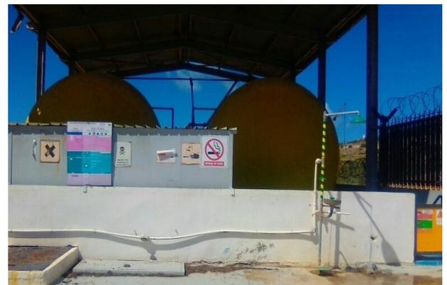
**Figure IV-7:** Réservoir de stockage d'Hypochlorite de sodium. [47]
