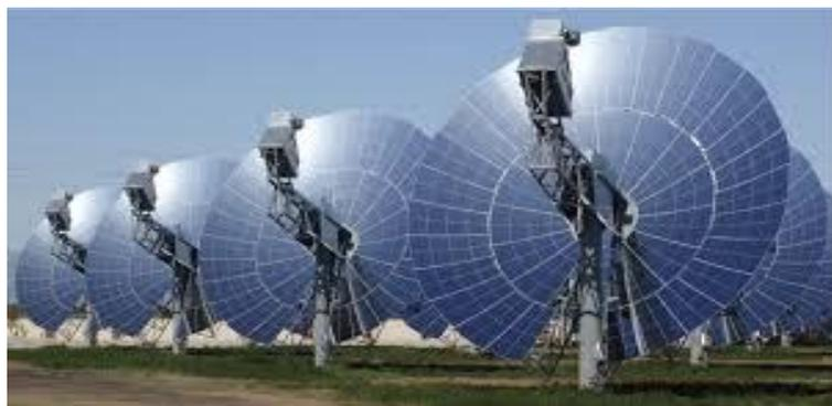
**Figure III- 11:** Capteurs solaires paraboliques. [44]
