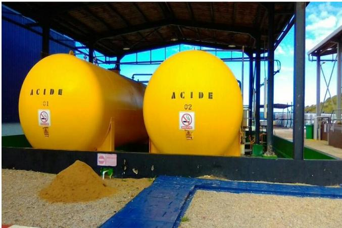
\* Bâtiment d'acide sulfurique avec 2 réservoirs en acier de 100 m<sup>3</sup> chacun.
