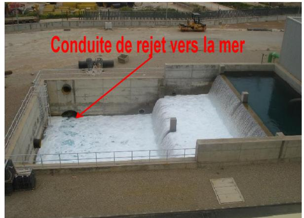
**Figure IV- 22:** Bâtiment de saumure où l'eau de rejet de saumure. [47]
