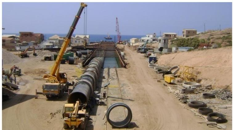
Figure IV- 3: Préfabrication de l'émissaire DN 2400. [47]
