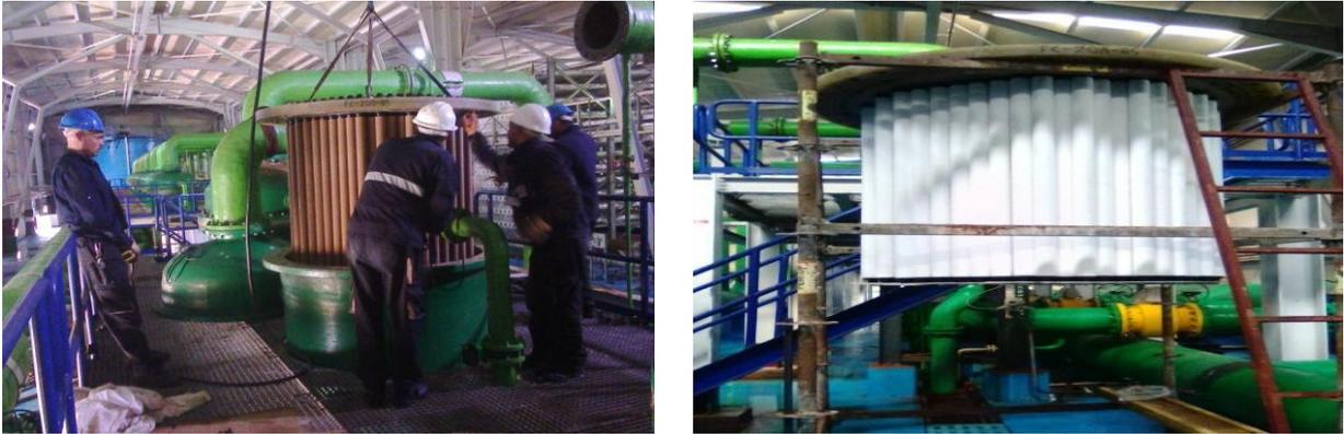
**Figure IV- 16:** Changement d'un filtre colmaté. [30]
