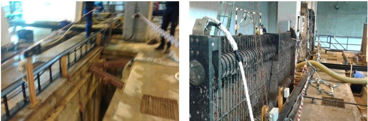
**Figure IV-8:** Le dégrillage pour éliminer les plus gros déchets. [49]
