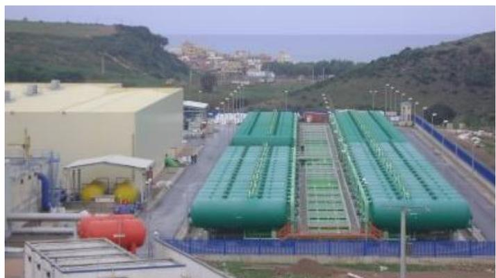
Figure IV- 13: Zone des filtres à sable et anthracite. [30]
