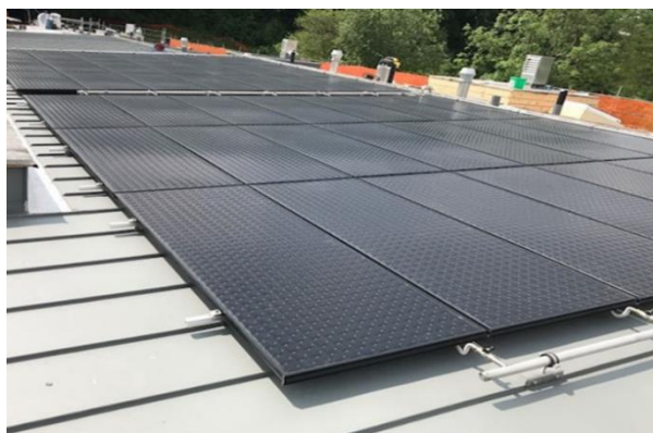
Figure I. 8: Capteur plan non vitré. [4]
