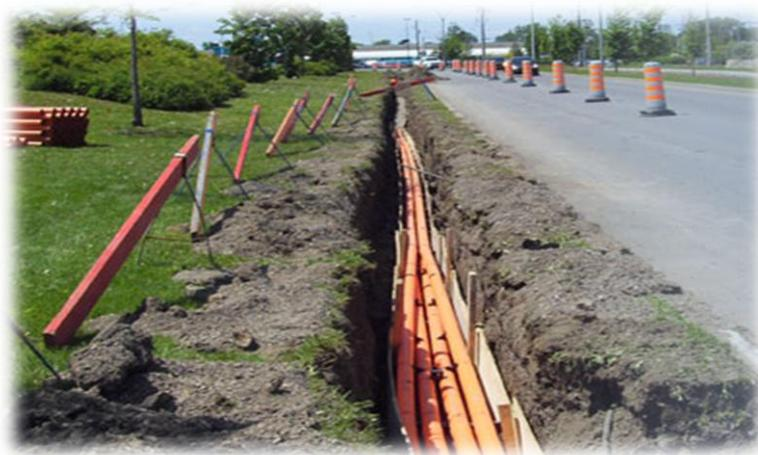
**Figure I.9 :** Pose en conduits [7].
