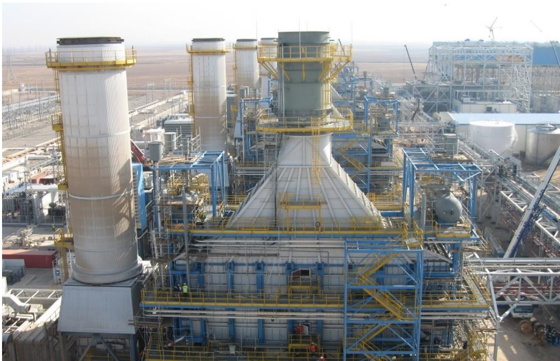
Figure II.3 Chaudière de récupération de chaleur (circuit primaire)
