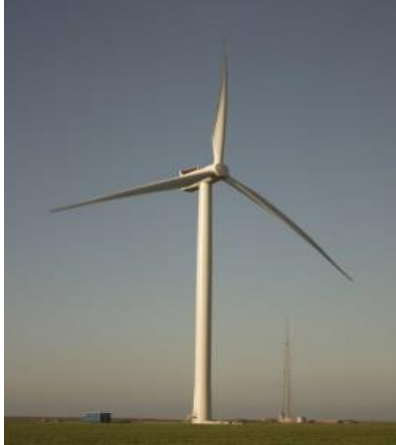
Figure.II.8 Exemple d'éolienne à axe horizontal [34]
