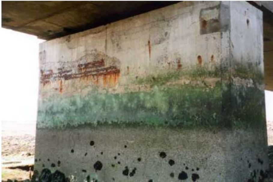
**Figure I.2:** Corrosion des armatures d'une pile de pont
