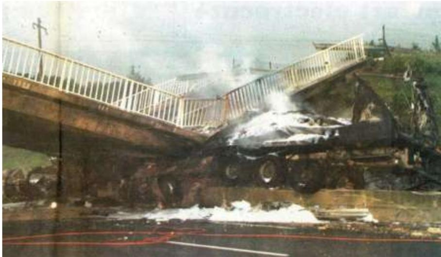
**Figure I.5:** Effondrement d'un pont lors d'un violent choc de poids lourd
