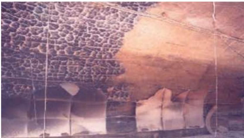
**Figure I.6:**Béton faïencé dans un tunnel suite à un incendie
