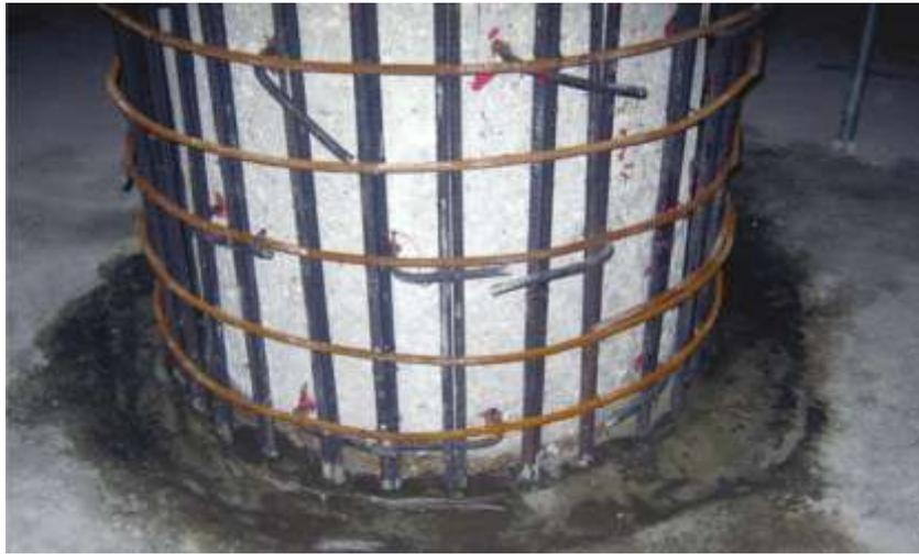
**Figure I.11:**Chemisage en béton d'un poteau en béton armé
