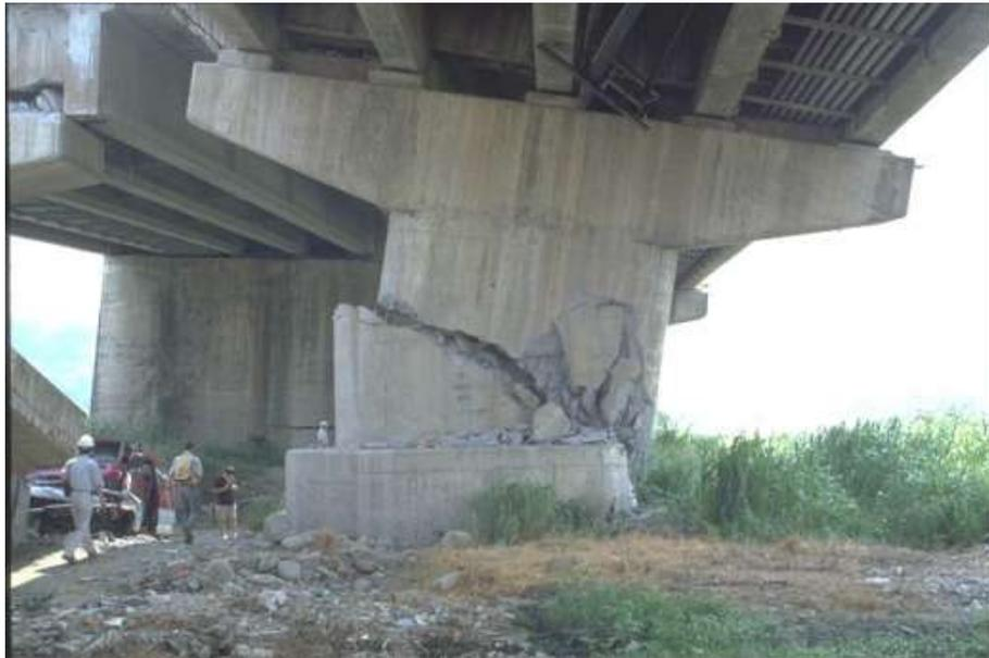
**Figure I.3:**Ruptures par cisaillement des piles (Taiwan, 1999)
