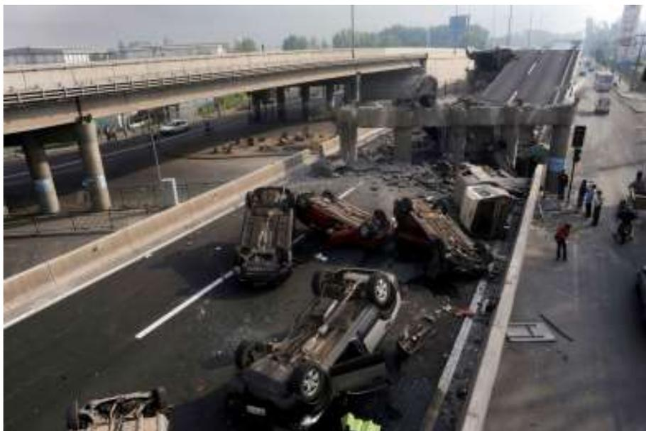
**Figure I.4:** Echappement d'appui (Chili, 2010)
