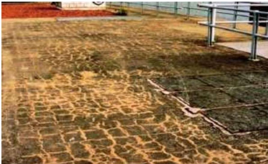
**Figure I.1:** Faïençage résultant d'une alcali-réaction
