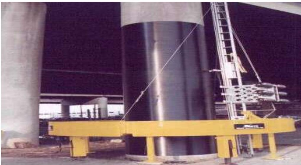
**Figure II.16:** Procédé de l'enroulement filamentaire
