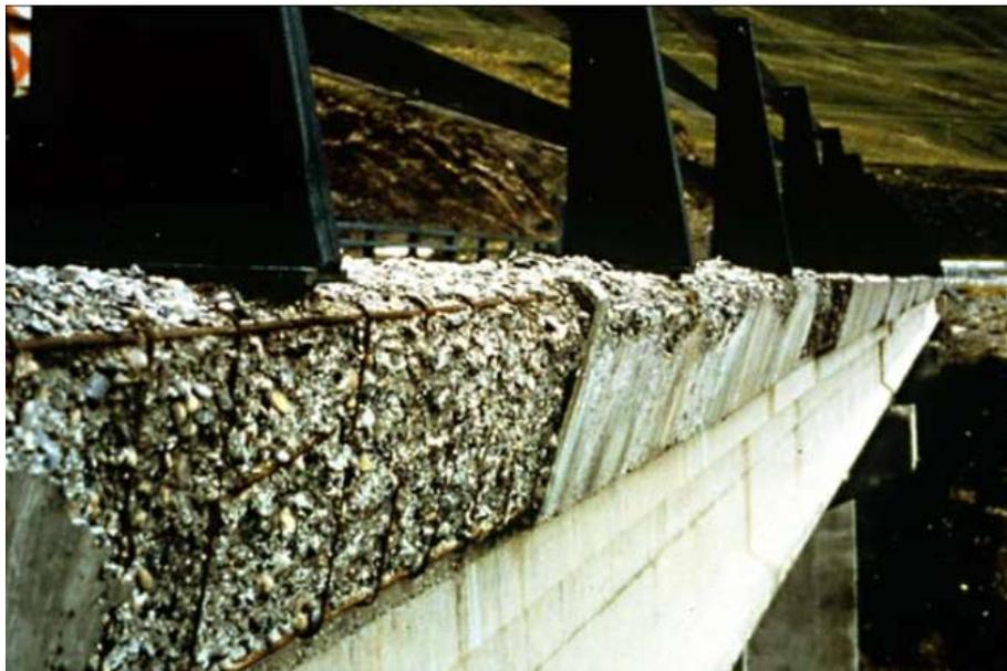
**Figure I.8:** Écaillage et éclatement de béton sur corniche de tablier
