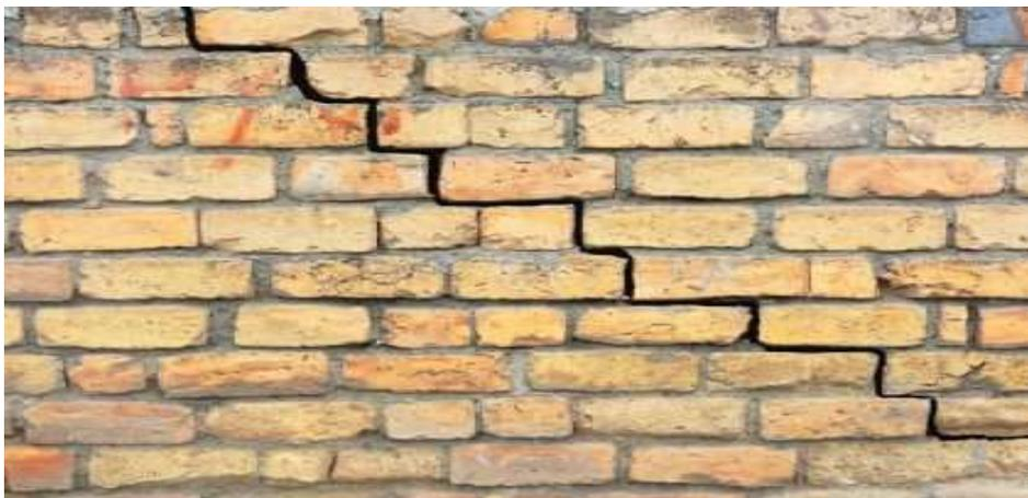
**Figure I.7:** Fissures en forme d'escalier sur un mur de bâtiment
