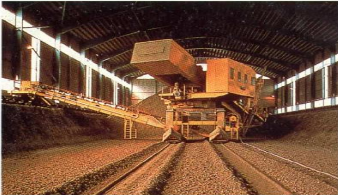
Figure I.10: Hall de pré-homogénéisation. [5]
