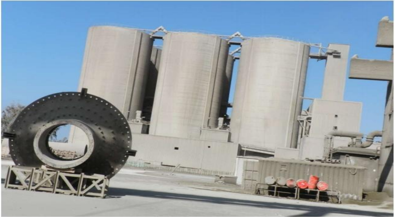
Figure I-16 : Silos de stockage de ciment.
