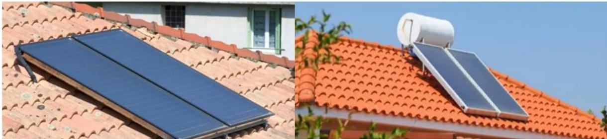
Figure I.18 : capteur plan à air et à eau[22-23].
