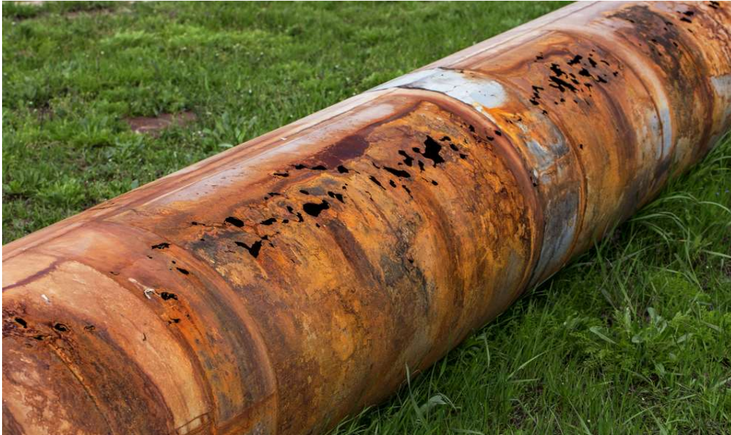
Figure II. 1:corrosion dans un pipeline.[15]
