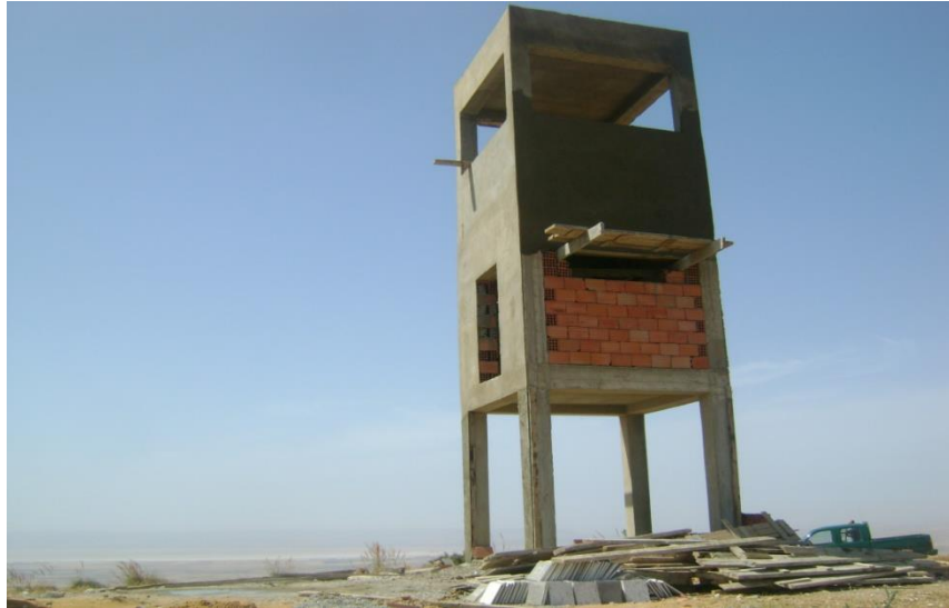
Photo 05 : Construction d'un poste de vigie
