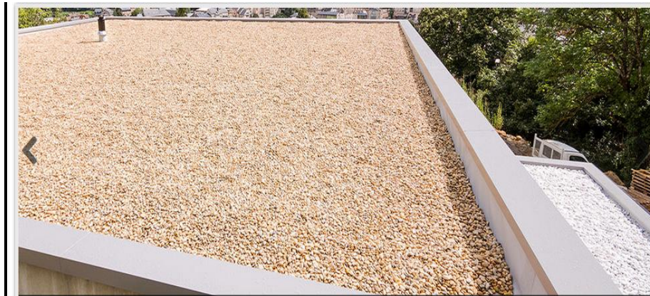
Figure IV - 1: acrotère d'une terrasse inaccessible
