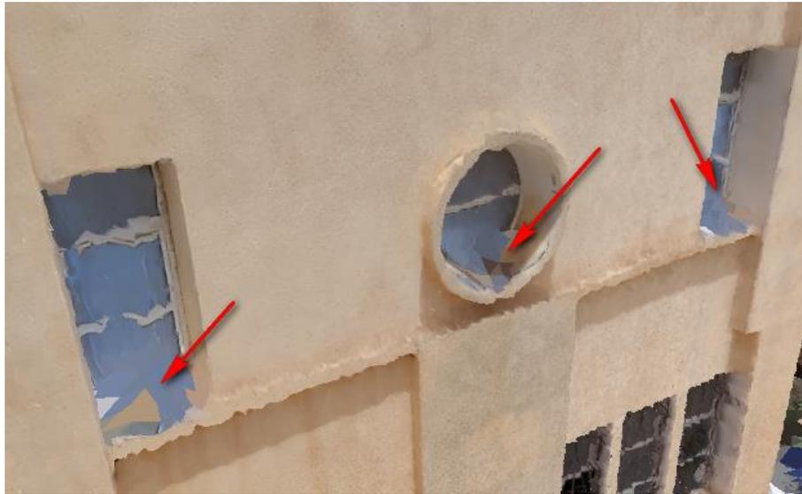
**Figure 195 : les déformations des vitres du 1er étage de la façade**
