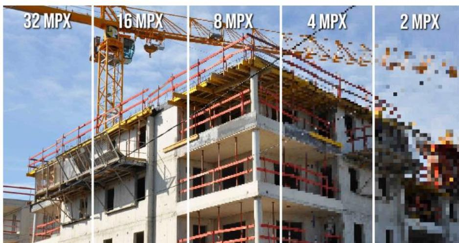
**Figure 80 : La résolution d'une photo détermine la quantité d'informations utilisable en photogrammétrie. [38]**
