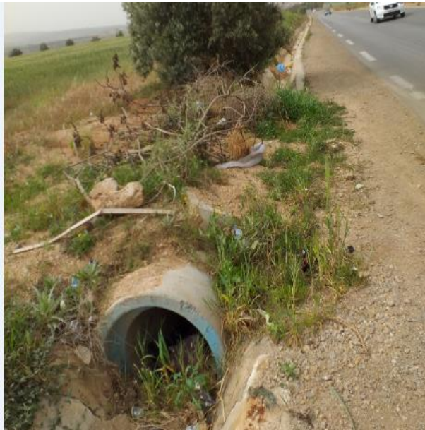
Figure 21 : Photo réel de l'ouvrage busé
