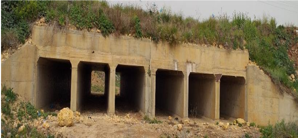
Figure 20 : Photo réel du dalot n°2 dans l'évitement de Chabat dimension 6(3x3)
