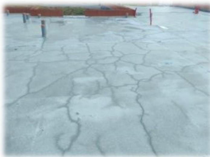
**Figure 1.2** exemple de fissuration à un retrait plastique sur une dalle béton.
