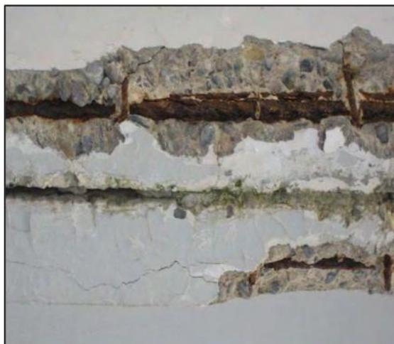
**Figure 1.5** Eclatement du béton d'enrobage dû à la carbonatation [10] .
