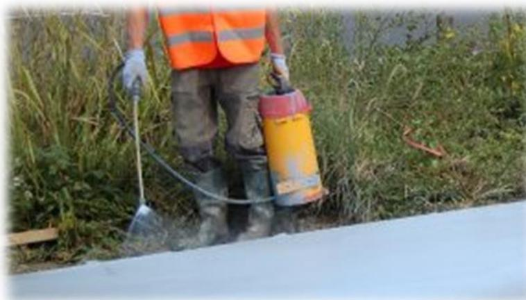
**Figure 1.3.** Application de produit de cure sur béton
