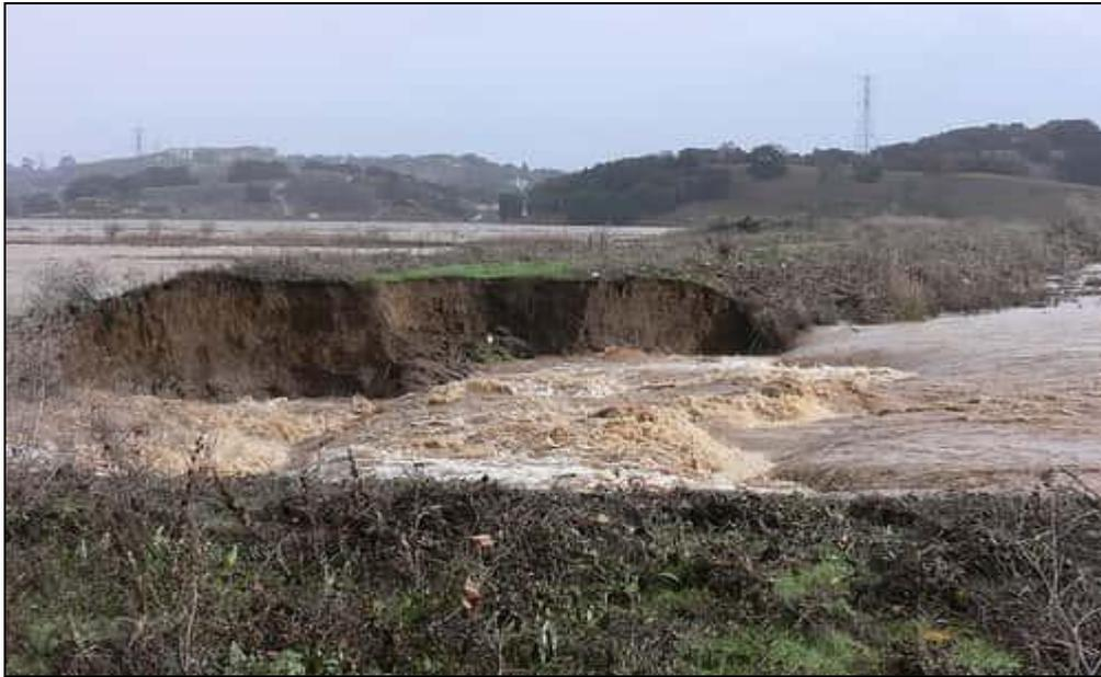
Photo1.1-RUPTURE D'UNE DIGUE EN CALIFORNIE (ANNEE 2005)
