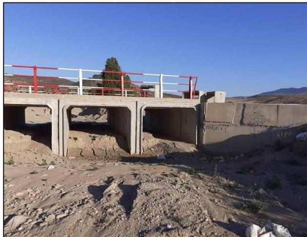
**Figure 2.7 : Dépôt de sédiments fins (boues) déposés au niveau du pont**
