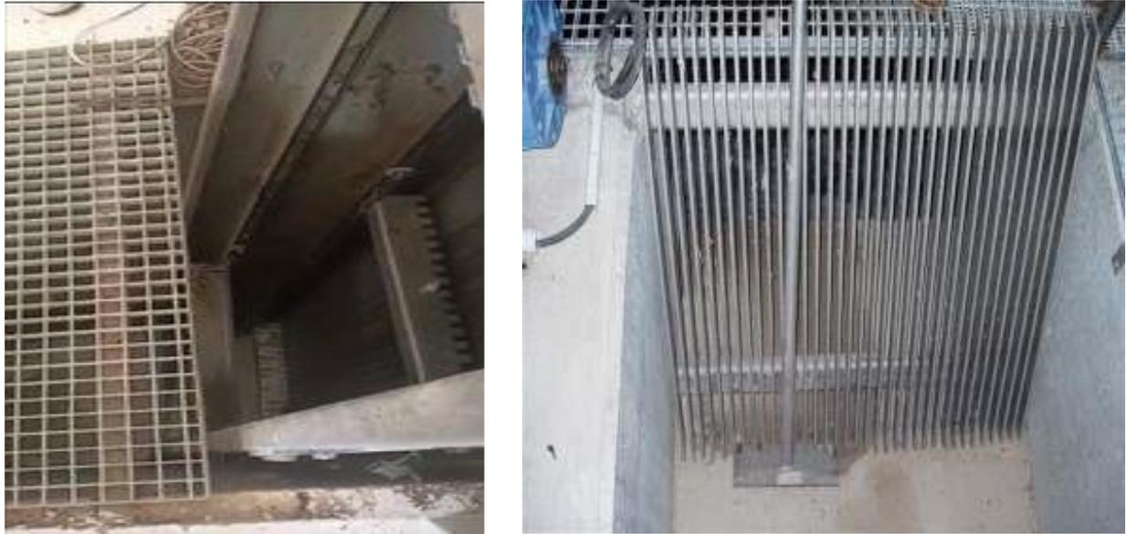
**Figure N°5 : Batiment de prés traitement (Dégrillage grossière .3**
