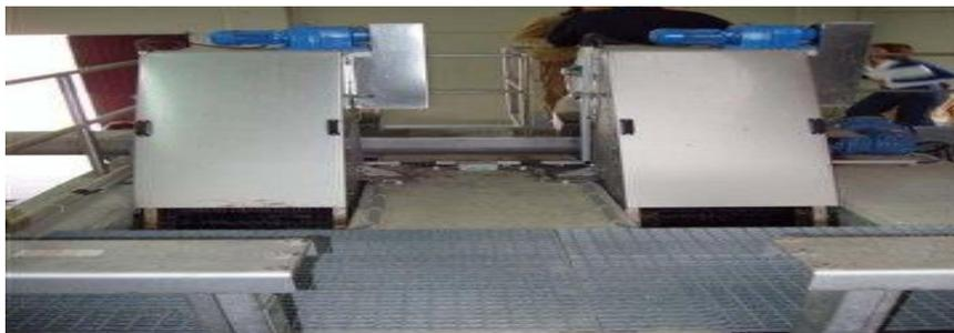
**Figure N°6: batiment de prés traitement Dégrillage fines (2023).**
