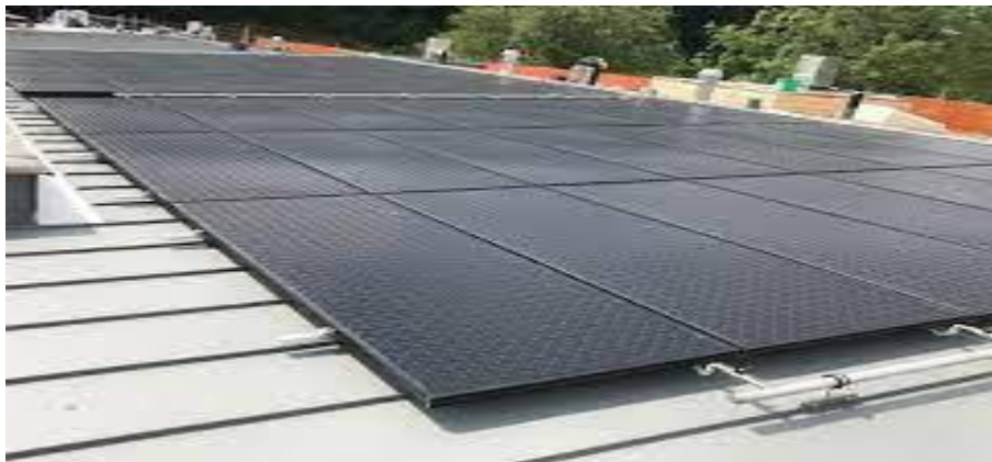
Figure .I.10 : Capteur solaire sans vitrage [13]
