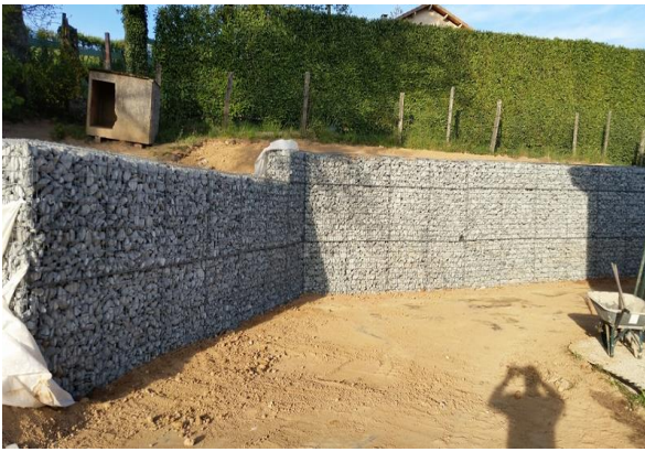
Figure II.20 Réalisation un mur en gabions (Youcef tani,2021).
