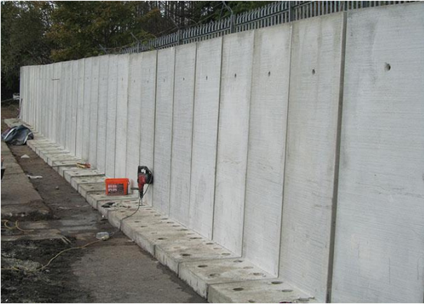
Figure II.18 Mur en béton armé préfabriqué (Youcef tani,2021).
