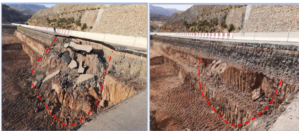
Figure III. 13 Vue en perspective de la zone excavé PK8+203 au PK8+233 [28]
