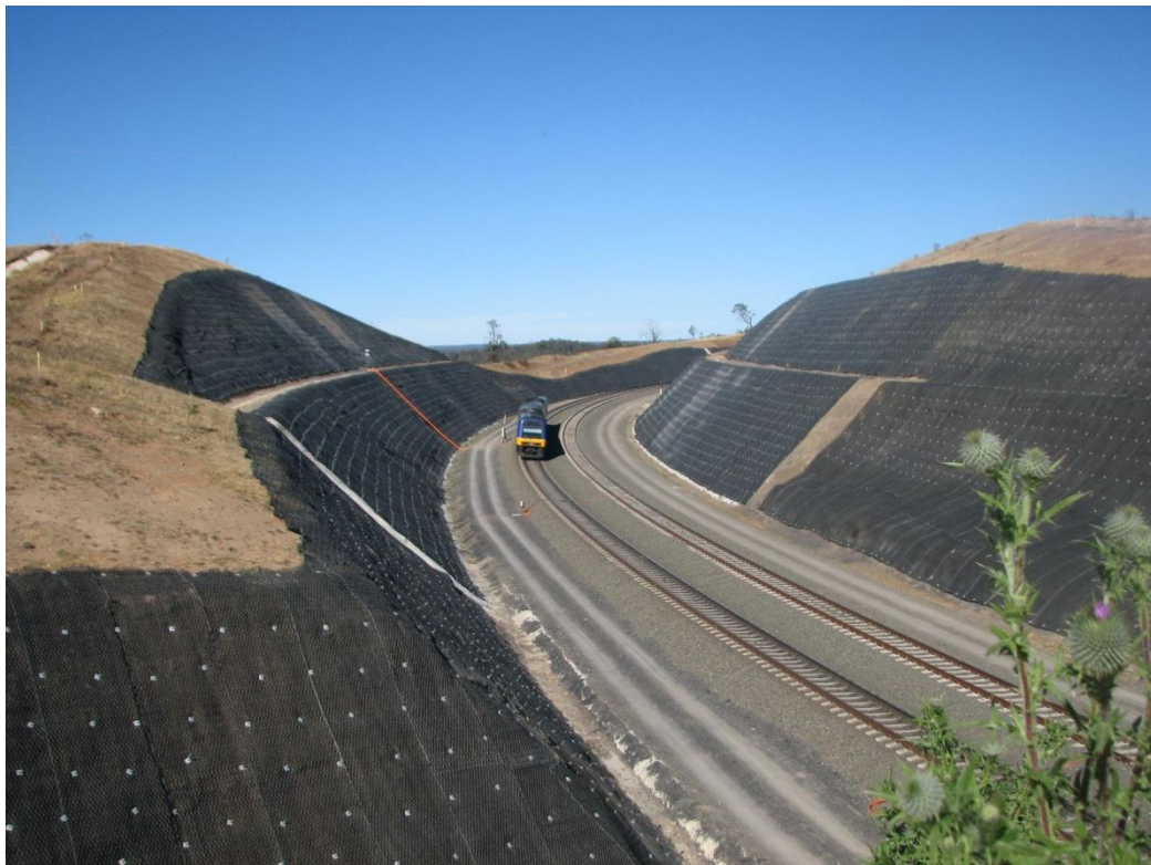
Figure II.16 Un versant stabilisé par clouage (Maccaferri France).
