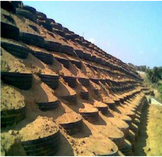
Figure II.13 Chantier Moutiers-mur expérimental pneu sol à Bou-Smail.
