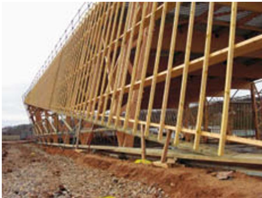
Figure 2.11. Ossatures en bois triangulées.
