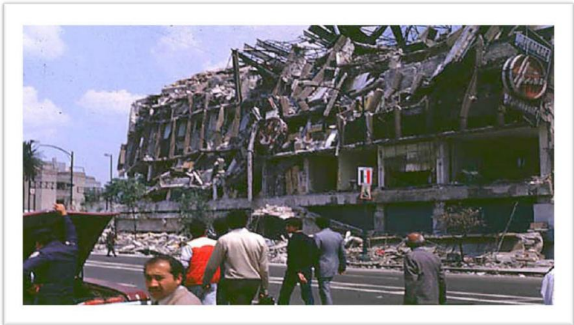
Figure 1.5. Dommages sismiques dus à la résonance du bâtiment avec le sol.
