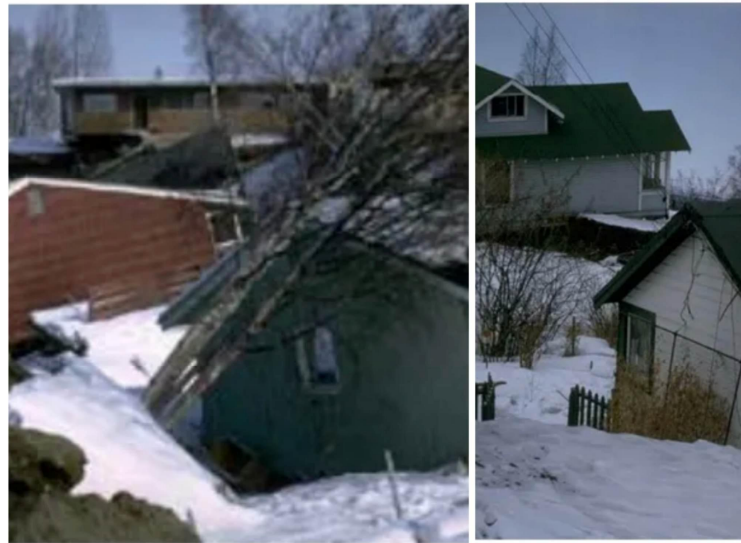
Figure 1.15. Maisons en bois non effondrées malgré un important glissement de terrain, séisme d'Anchorage, Alaska 1964.
