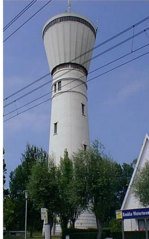
Figure 4-5 Réservoir de fût conique avec fût inverse de capacité 200 m 3
