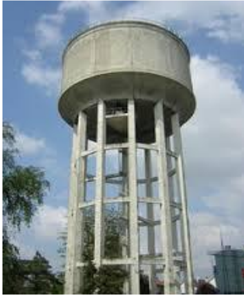
Figure 1.11. Pylône sur poteau
