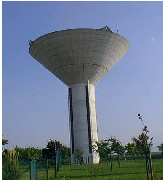
Figure 4-3 Cuve à fort encorbellement capacité de 1600 m 3
