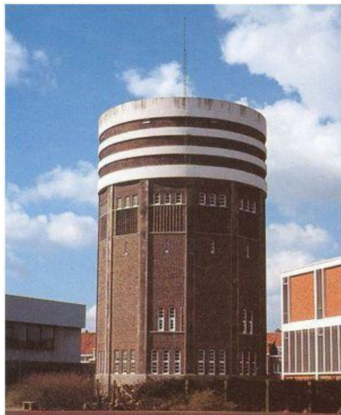
Figure 4-1 Réservoir de type colonne capacité 1000m 3
