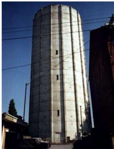
Figure 4-3 Réservoir de type colonne de capacité 700 m 3
