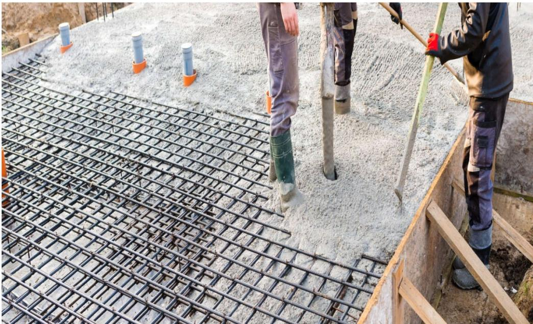
Figure V.4 : Réaliser un radier en béton armé
