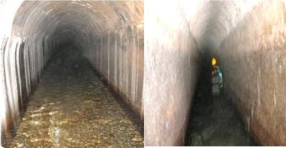
*Figure1.5: La canalisation pour l'alimentation de La fontaine de Trevi[12]*
