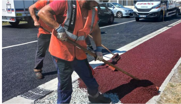
Figure 13 : exemple Revêtement en asphalte modifié
