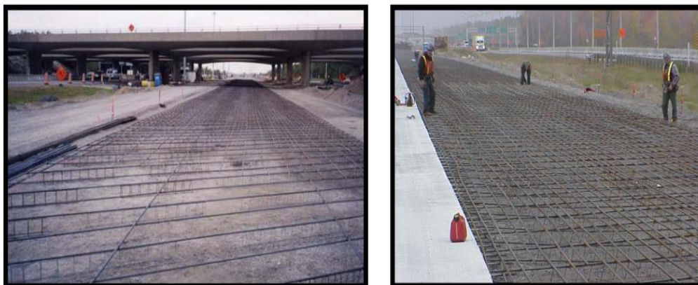
Figure 4 : Chaussée en béton armé continu (BAC)
