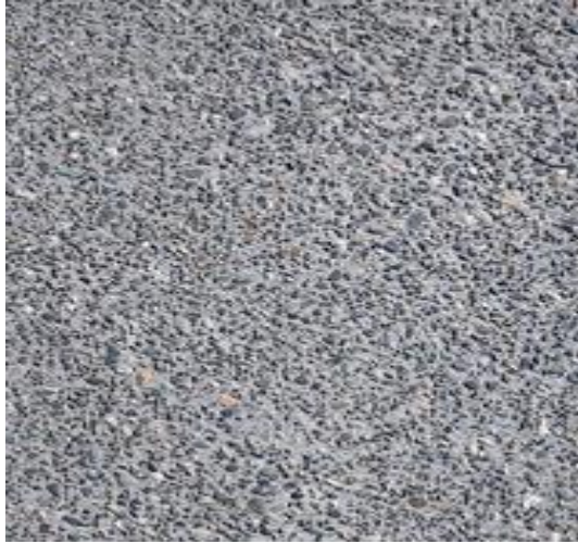
Figure 5 : Chaussée en béton désactivé
