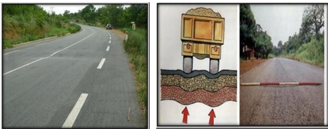
Figure 36 : Schématisation d'un affaissement transversal et longitudinal[15]
