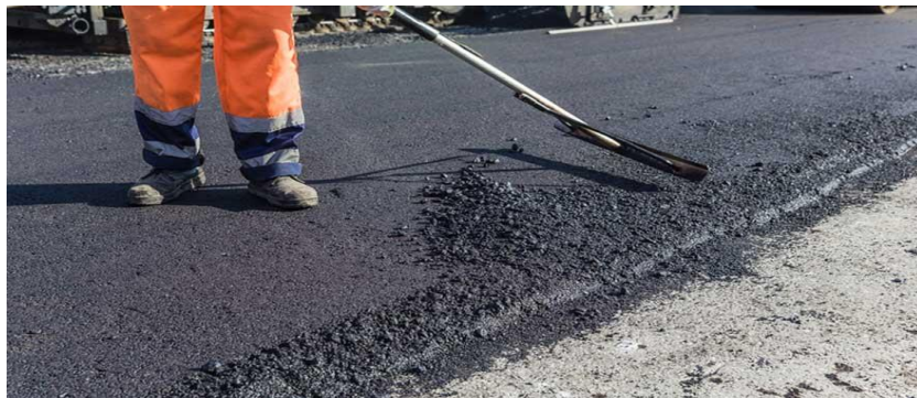
Figure7 :Chaussée en béton bitumineux (BBG)
