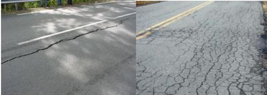
Figure 37 : fissuration longitudinal
