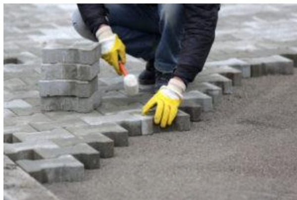
Figure 6 : pose du pavé autobloquant
