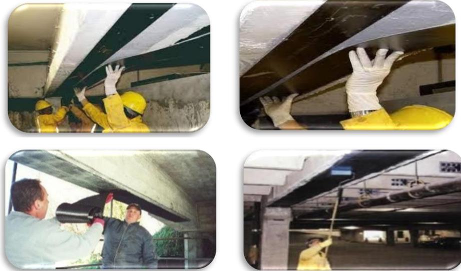
**Figure 2.1:** Renforcement par collage de plaques composites.
